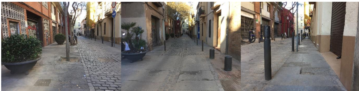
Imagen 55 Imagen 56 Imagen 57 Levantamiento fotográfico, estado de calle de Otger. Archivo propio de imágenes.
