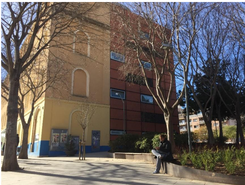
Imagen 50 Remate de un extremo del edificio de Can Fabra. Un grupo de árboles en forma de masa verde componen un espacio es desecando y estar, apartado del resto del gran espacio pero al mismo tiempo integrado. Archivo propio de imágenes.
