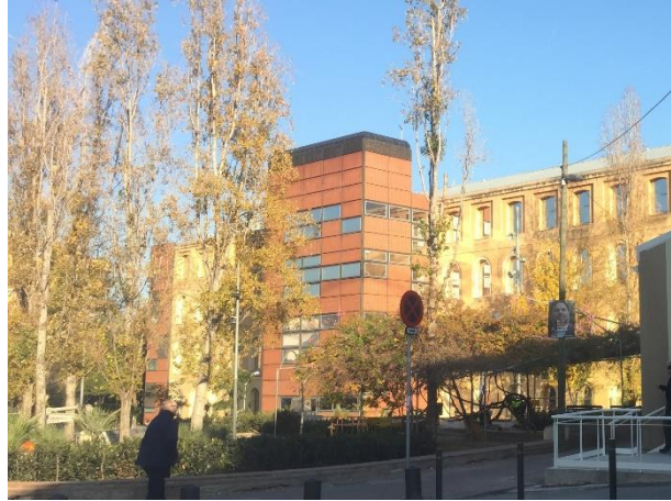
Imagen 31 Fachada trasera edificio Can Fabra. Archivo propio de imágenes.
