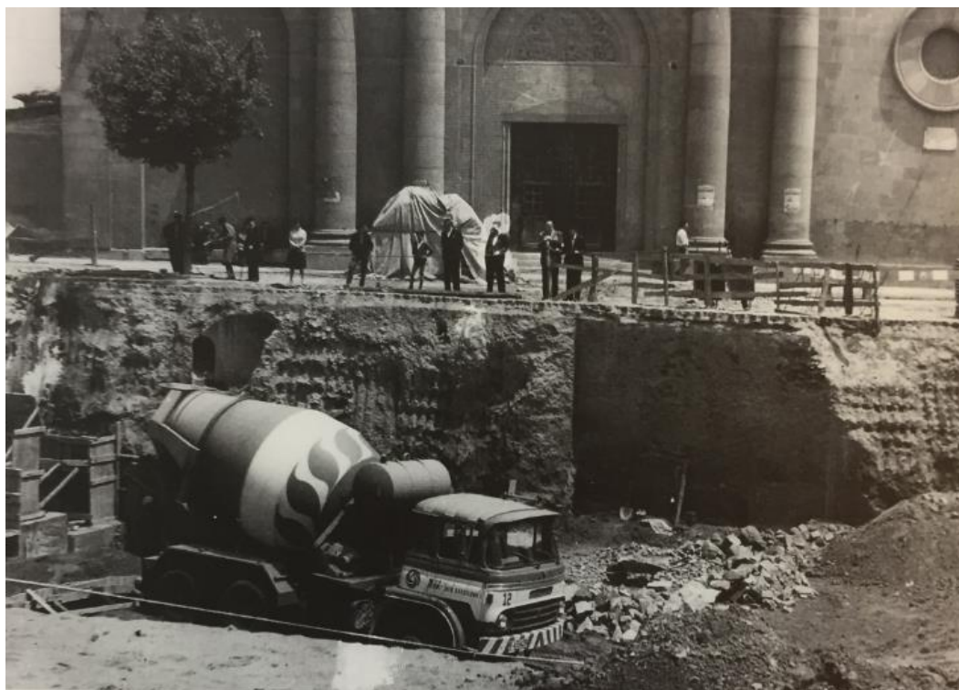
Imagen 95 Obras de la plaza de Orfila. DETRÁS Parroquia de Sant Andreu. FUENTE: Sant Andreu de Palomar I La Sagrera: Com Era Y Com És. Roig. 2009
