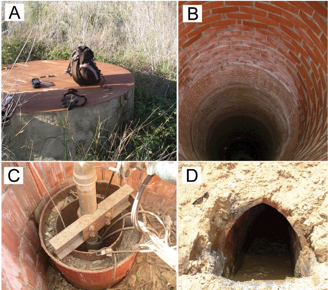
Figura 9. Diferents captacions d'aigua subterrània localitzades a la riera de Sant Pol. A i B, antic pou "La Bomba", pou de gran diàmetre construït manualment i actualment abandonat (al fons s'aprecia el reflex de l'aigua). C, pou de petit diàmetre construït per mitjans mecànics i dotat de bomba submergida elèctrica per a l'extracció de l'aigua subterrània. D, mina d'aigua en el sauló del marge esquerre de la riera de Sant Pol, tallada per les excavacions d'una obra (Autor: J.M. Carmona).
