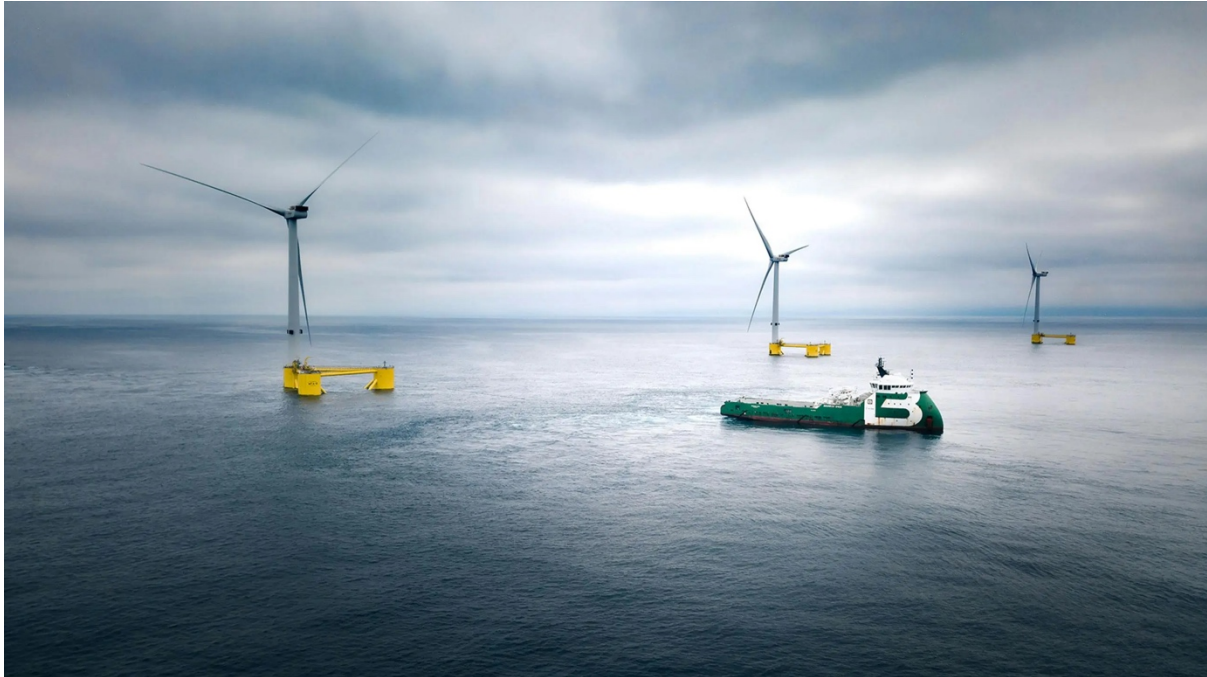
Figura 4.2: Plataforma semisumergible WindFloat® utilizada en el proyecto WindFloat Atlantic. (Fuente: Principle Power)
