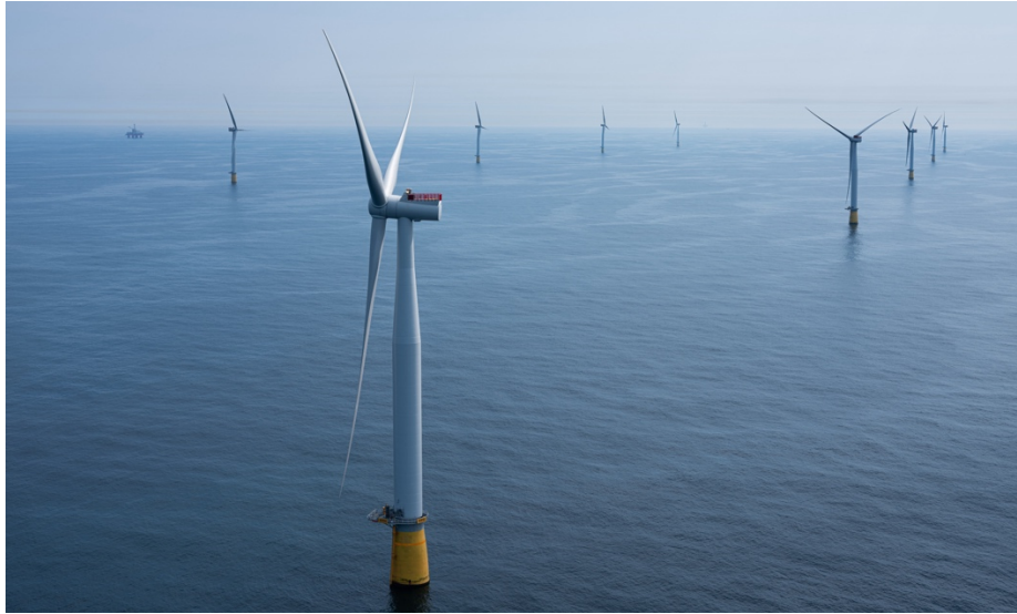
Figura 4.3: Plataforma tipo Spar del proyecto Hywind Scotland. (Fuente: Equinor)
