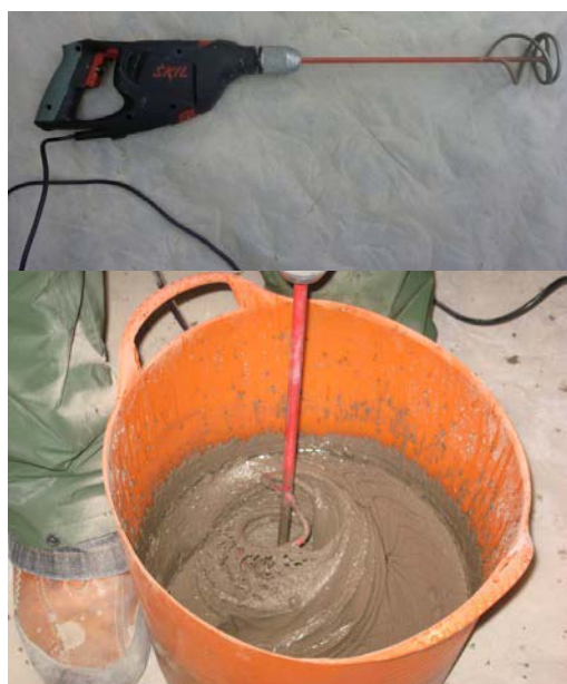
Figura 6.1 Máquina taladradora con hélice (arriba) y ejemplo de realización de la amasada (abajo)
