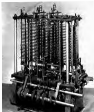
Una de les primeres temptatives de fer un ordinador: una calculadora victoriana, dissenyada per Charles Babbage (1791-1871).
