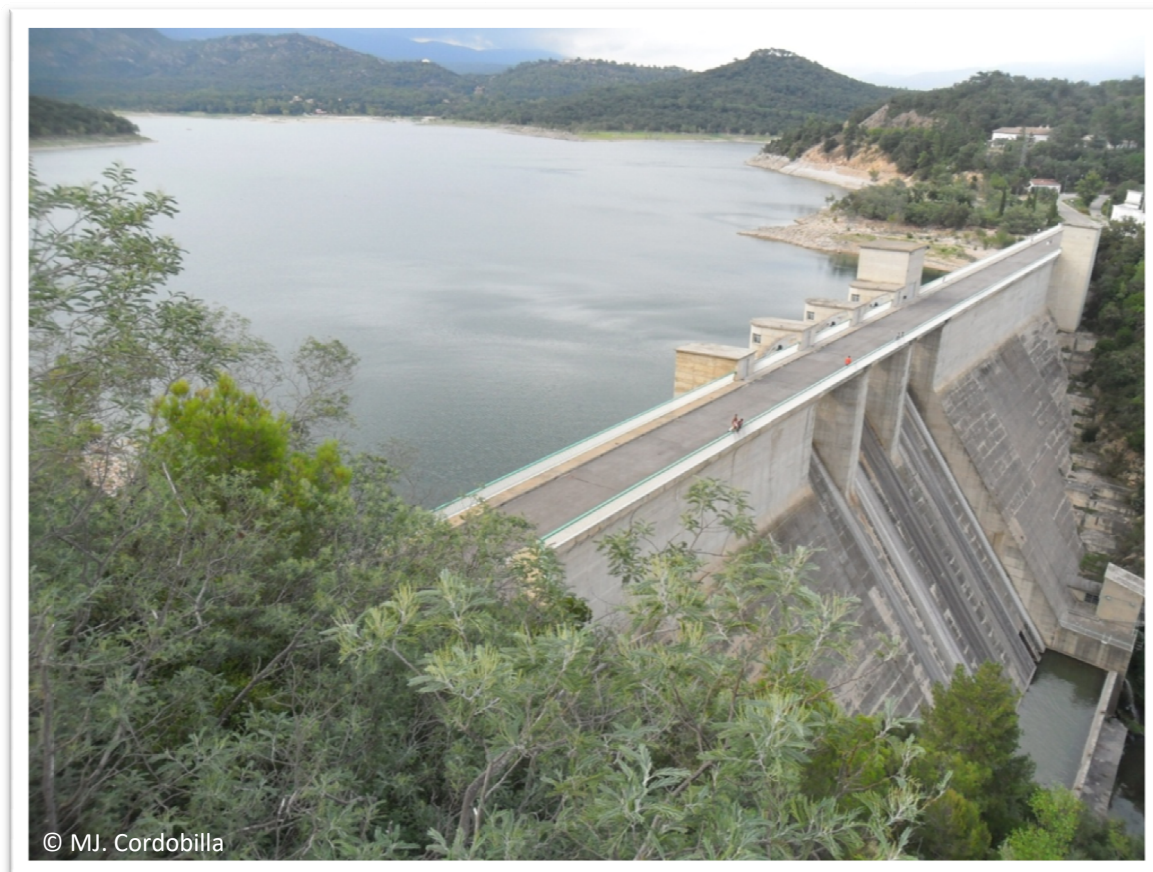
Fotografía 7. Vista panorámica de la presa de Boadella y del embalse Darnius-Boadella.
