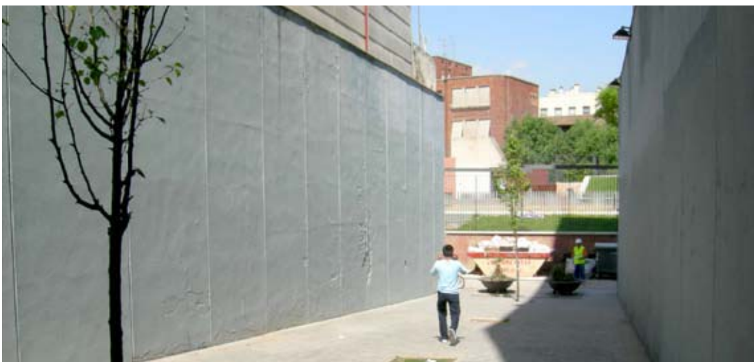
IMAGENS 170 E 171 - PASSATGE DEL CARRER NOU DE LA RAMBLA
