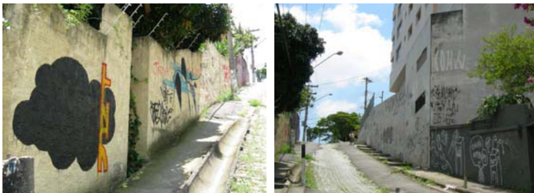
IMAGENS 232 E 233 - TRAVESSA TIM MAIA, PRIMEIRO TRECHO
