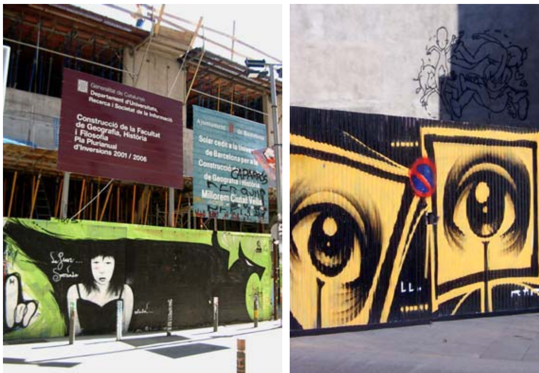
IMAGENS 76 E 77 - C/ DE MONTEALEGRE. OBRAS DA UNIVERSIDADE
