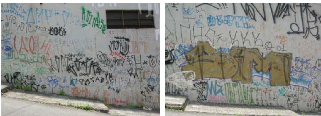
IMAGENS 236 E 237 - TRAVESSA TIM MAIA, PRIMEIRO TRECHO
