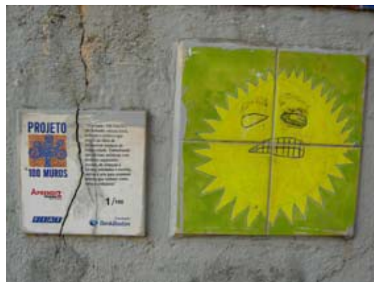
IMAGEM 506 - PROJETO "100 MUROS", R. NOVA VENEZA
