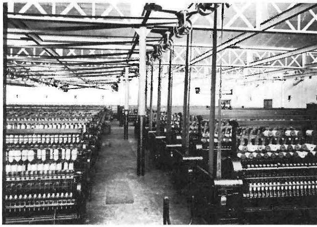
Fot. 15. Fotografia de "Can Carol". Tenim davant una sala de màquines retorçadores. La funció d'aquestes màquines és completar el filat, tornar a retòrcer el fil per tal que quedi més retorçat, més fort i més prim.
