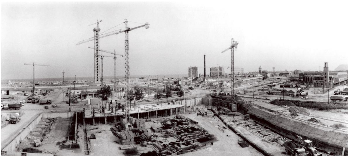
Vista panorámica del inicio de los trabajos de edificación en el sector Av. Icària entre c/Juan Miró y c/ de la Marina. Mayo 1990.
