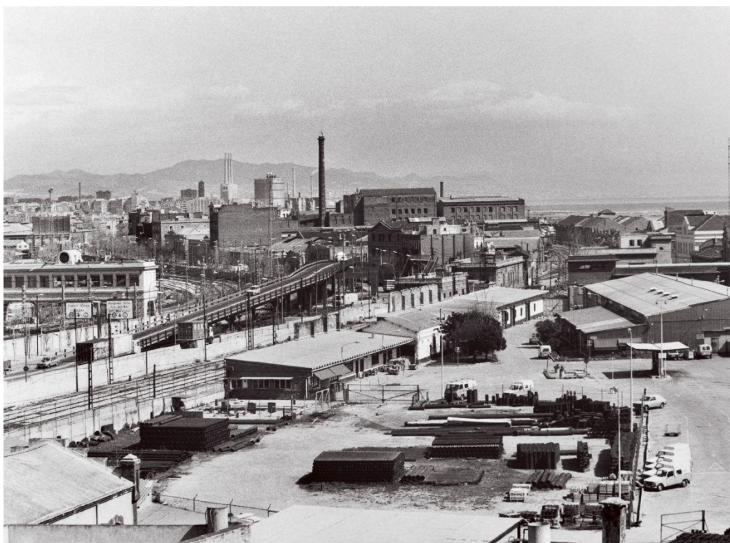
Las fábricas del sector de Av. Icària vistas desde la Barceloneta. En primer término, las instalaciones de Catalana de Gas. Marzo 1986. Fuente: Archivo Fotográfico Martí Llorens. En: http://bcn87-92.tempusfugitivisual.com/fot-doc/barrio-de-icaria-el-manchester-catalan/
