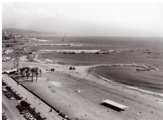
Vista general de la construcción del Port Olímpic y de los espigones del Bogatell y Bac de Roda. Septiembre 1988.
