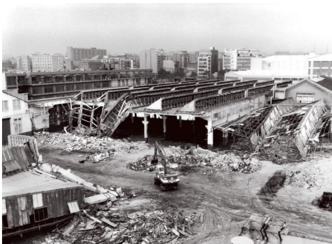
Vista general del derribo de las naves industriales en la fábrica Motor Ibérica. Octubre 1988
