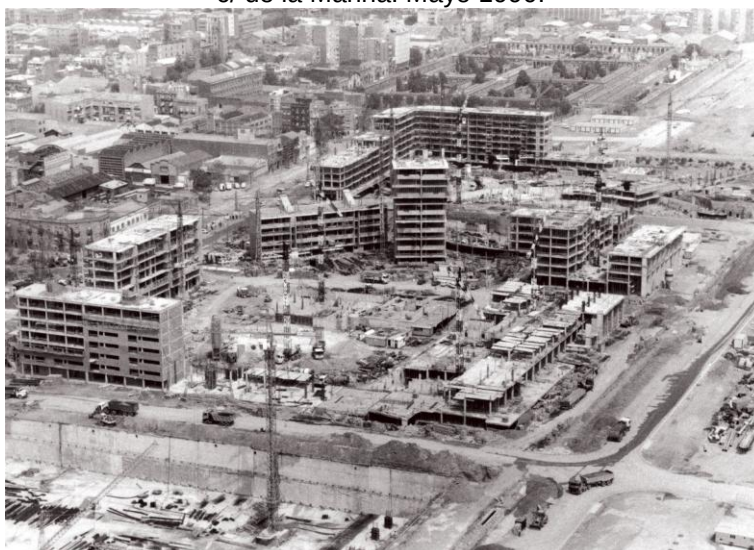
Unidad de Proyecto 8.2 en construcción vista desde la Torre Mapfre. Dicho proyecto, situado entre la c/de l'Arquitecte Sert y c/Juan Oliver es obra de los arquitectos Helio Piñón, Albert Viaplana y Robert Mercadé como arquitecto asociado. Agosto 1990
