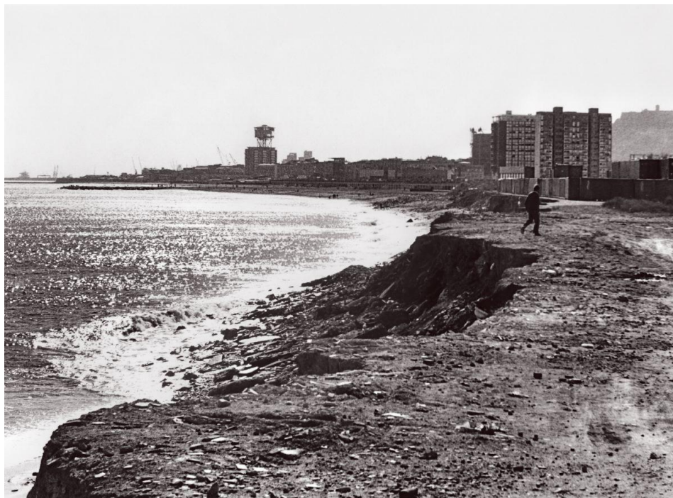
Aspecto general de la playa del Somorrostro antes del inicio de los trabajos de recuperación de la costa. Febrero 1986
