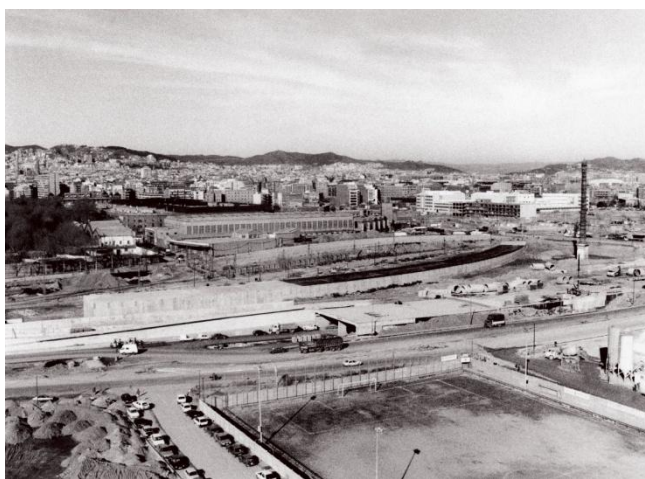
Vista general de la entrada del soterramiento. En primer término, el antiguo campo de fútbol de la Barceloneta y las obras de la ronda litoral. Diciembre 1989
