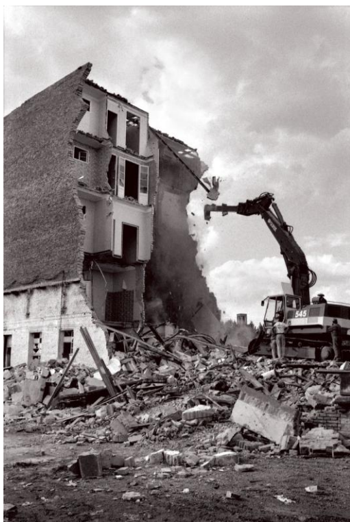
Derribo del edificio de viviendas Herederos Sanllehy Girona, en la Av. Icària 98-100. Agosto 1987
