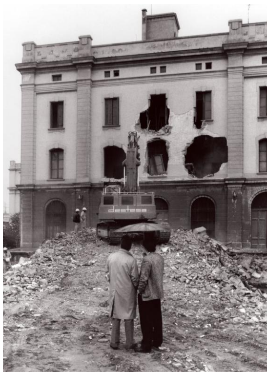
Inicio del derribo de uno de los edificios ferroviarios en la Av. Icària. Mayo 1989
