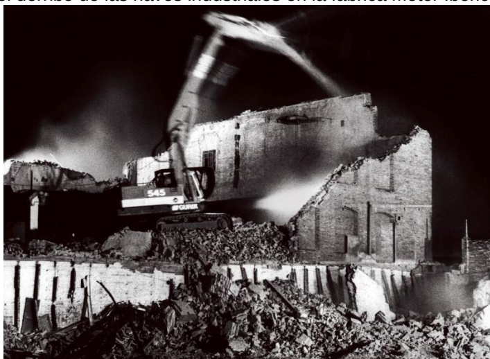
Derribo nocturno en Fábricas Folch . Dada la cercanía de las vías del ferrocarril, se realizaron algunos derribos nocturnos aprovechando la conclusión del tráfico ferroviario. Septiembre 1987
