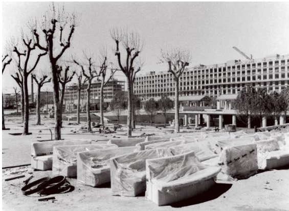
Acopio de mobiliario urbano durante la construcción del Parc del Port. Abril 1991
