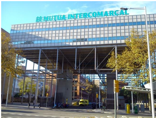
Edificio Mutua Intercomarcal
