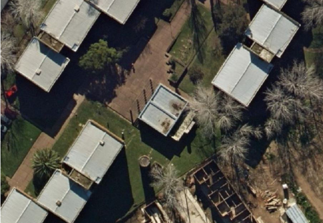
Imagen 17 - Salón comunal de CH 135, vista aérea
