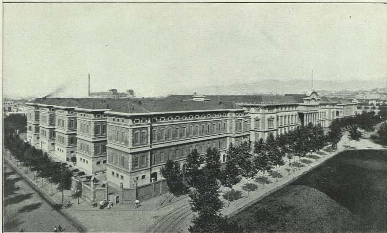
Fachada lateral de la Facultad de Medicina y Hospital Clínico. Calle de Provenza
