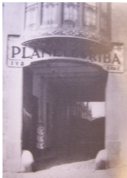
Fig. 118. Entrada de la fàbrica pel carrer Anglesola quan als inicis era Planell i Riba. Imatge: AMDC.
