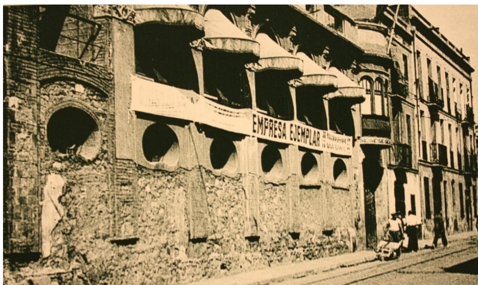
Fig. 150. Façana de la fàbrica a l'immediata postguerra (1940-1942). Imatge: J. Tapiola. AMDC.
