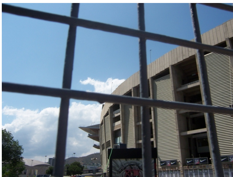
Fig. 322. Nova imatge de la connexió de la tercera graderia del gol sud, del Nou Camp del FC Barcelona en el seu enllaç amb la seva homòloga de la tribuna. Imatge: A. Brengaret i Framis, col·lecció particular.
