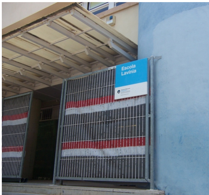
Fig. 278. Entrada accés al col·legi Lavinia. Imatge: A. Brengaret i Framis, 2016, col·lecció particular.
