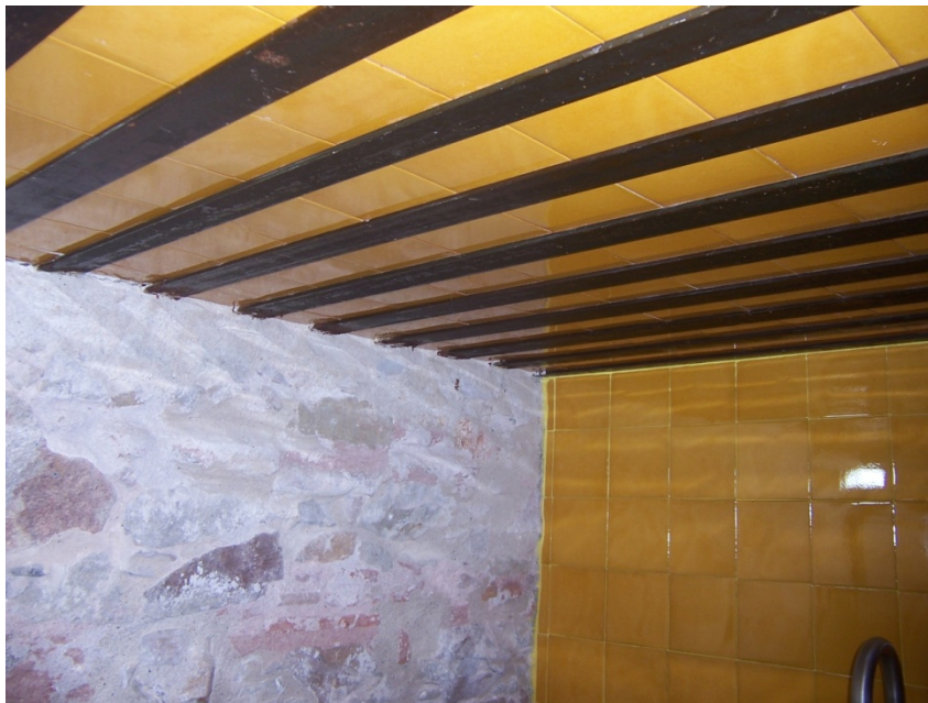
Fig. 177. Sostre, paret de pedra i part revestida de rajola vidriada d'una de les dependències de les oficines de la indústria Framis. Imatge: A. Brengaret i Framis, col·lecció particular.
