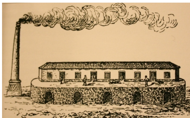
Fig. 218. Gravat del forn tipus Hoffmann de la bòbila Perelló-Macians. Imatge: "Anuario de la Asociación de Arquitectos de Cataluña, 1904".
