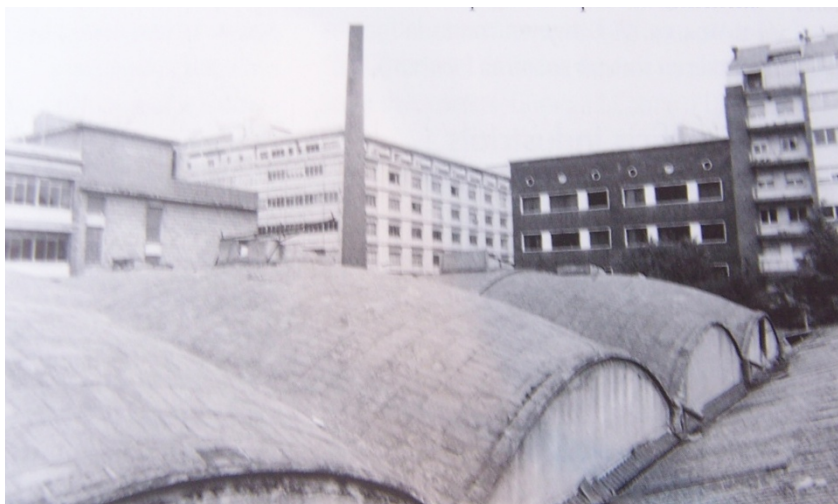
Fig. 202. Volta catalana de la coberta de la fàbrica, construïda segons l'estil de l'arquitecte Guastavino. Imatge: AMDC.
