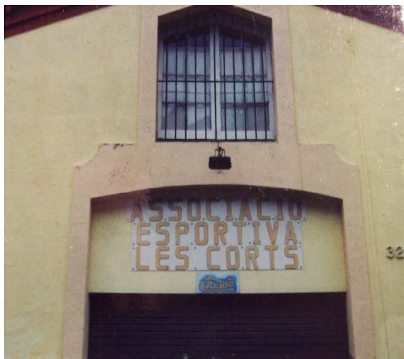
Fig. 293. Façana del que havia estat el primer Centre Parroquial de les Corts del carrer d'Anglesola núm. 32, avui desaparegut; en el seu lloc hi ha edificats habitatges. Imatge: A. Brengaret i Framis, 2009, col·lecció particular.
