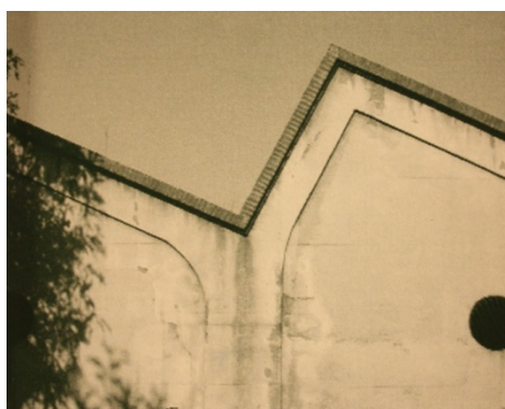
Fig. 215. Detall de la coberta de la fàbrica amb la forma tradicional en dent de serra. Imatge: A. Vilanova. AMDC.
