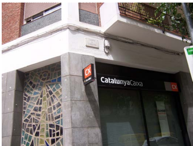
Fig. 313. Edifici d'habitatges antigament ocupat pel cinema Loreto. Imatge: A. Brengaret i Framis, 2014, col·lecció particular.
