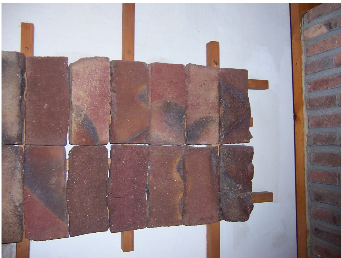
Fig. 178. Fotografia de peces de cagaferro, com les que va utilitzar l'arquitecte Antoni Gaudí en l'edificació de la Cripta de la Colònia Güell de Santa Coloma de Cervelló. Imatge: A. Brengaret i Framis, col·lecció particular.
