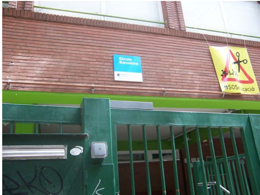
Fig. 288. Façana Escola Barcelona. Imatge: A. Brengaret i Framis, 2016, col.lecció particular.
