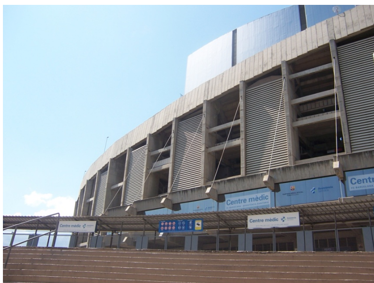
Fig. 320. Imatge de les graderies del gol sud, enllaçant amb la tribuna del Nou Camp del FC Barcelona. La barana de la part superior de la tercera gradaria, per un defecte de càlcul, va augmentant de mida a l'arribar a la tercera gradaria i connectar amb la tribuna, doncs a causa de l'error no encaixava i es va haver d'optar per aquesta solució per disimular l'error. Imatge A. Brengaret i Framis, col·lecció particular.
