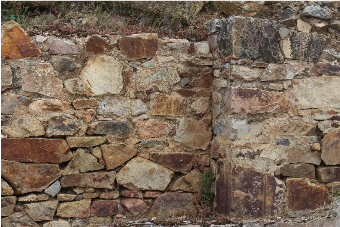
Fig. 41. Ejemplo de la ausencia de conexión de material entre pilastra y muro (autora).
