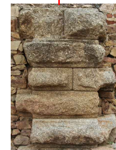
Tipo A. Modelo de pilastra con sillares pequeños y almohadillado regular
