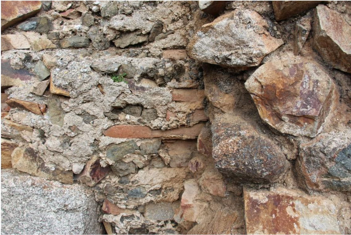
Fig. 39b. Detalle del núcleo del paramento externo (autora).
