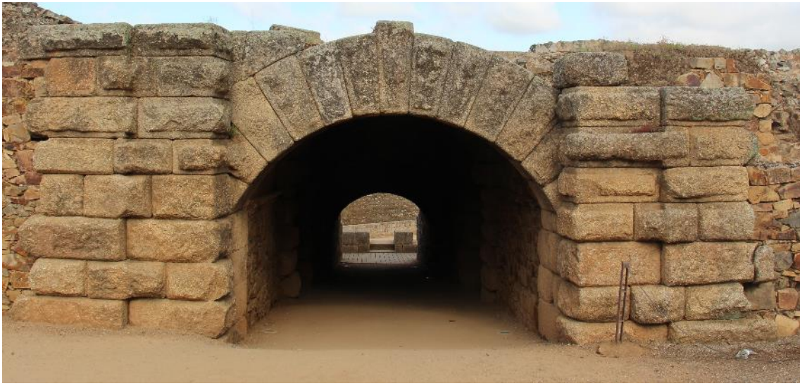
Fig. 8. Pilastras dobles que actúan como jambas del acceso 6 (autora).
