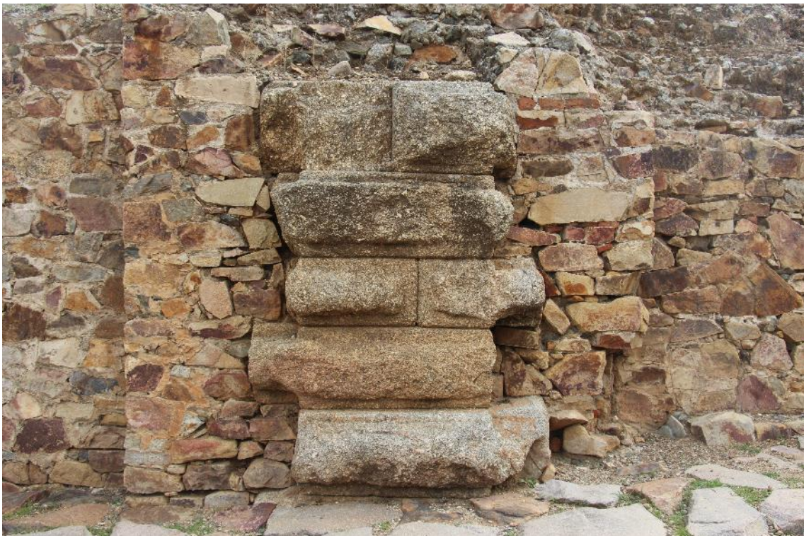
Fig. 9. Pilastra simple del tramo 2 (autora).
