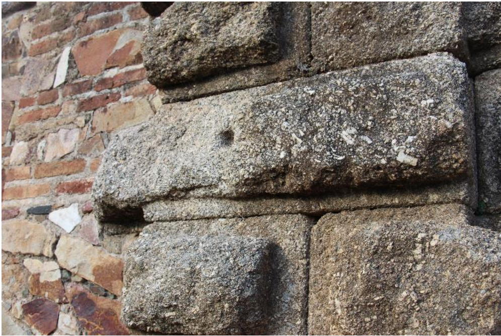
Fig. 32. Marcas de las garras sobre los sillares (autora).
