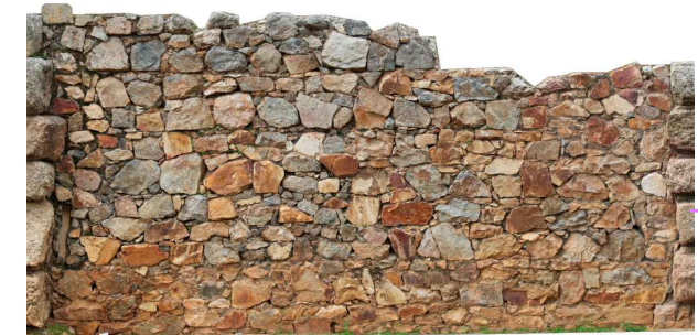
Tipo C. Modelo de paramento (variante desordenada)
