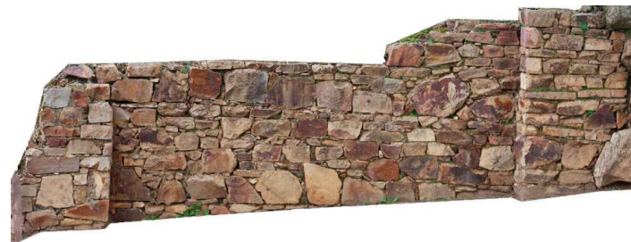
Tipo B. Modelo de paramento (variante con ladrillos)
