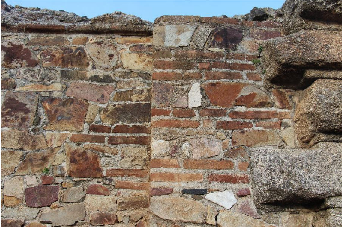
Fig. 45. Inclusión de opus mixtum en el tramo 1 (autora).
