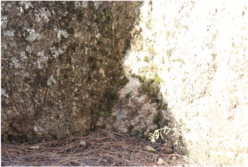
Fig. 36. Mortero entre los sillares de granito que conforman las pilastras (autora).
