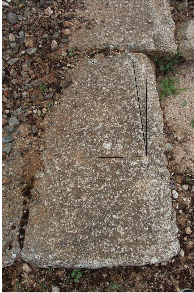
Fig. 24a. Marcas de trazado sobre el sillar de una pilastra (autora).
