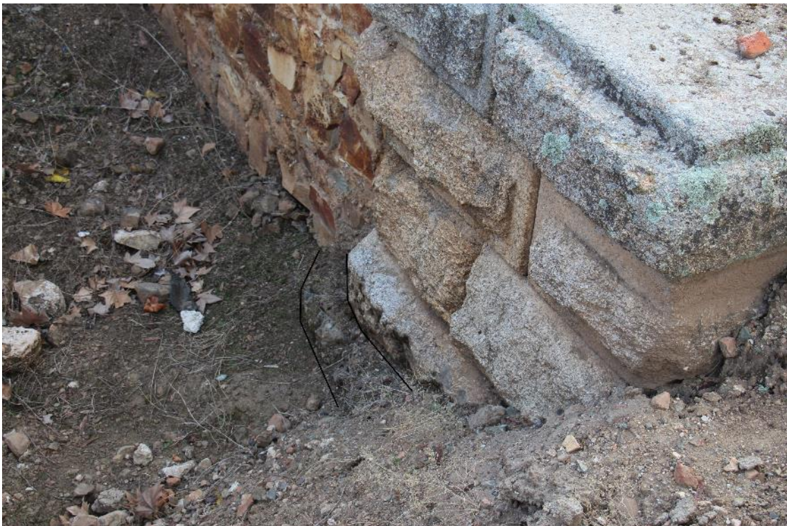
Fig. 21. Material geológico recortado para encajar con los cimientos de la pilastra granítica (acceso 10) (autora).
