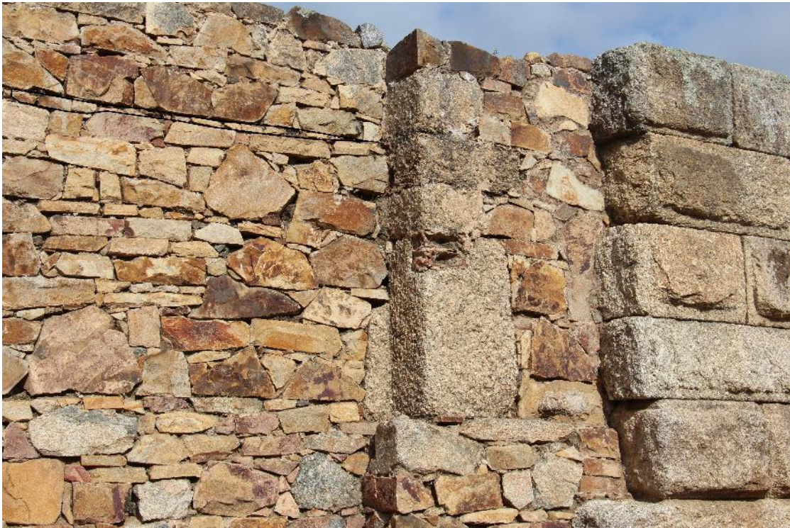
Fig. 43. Empleo de cuñas como herramienta de nivelación (autora).
