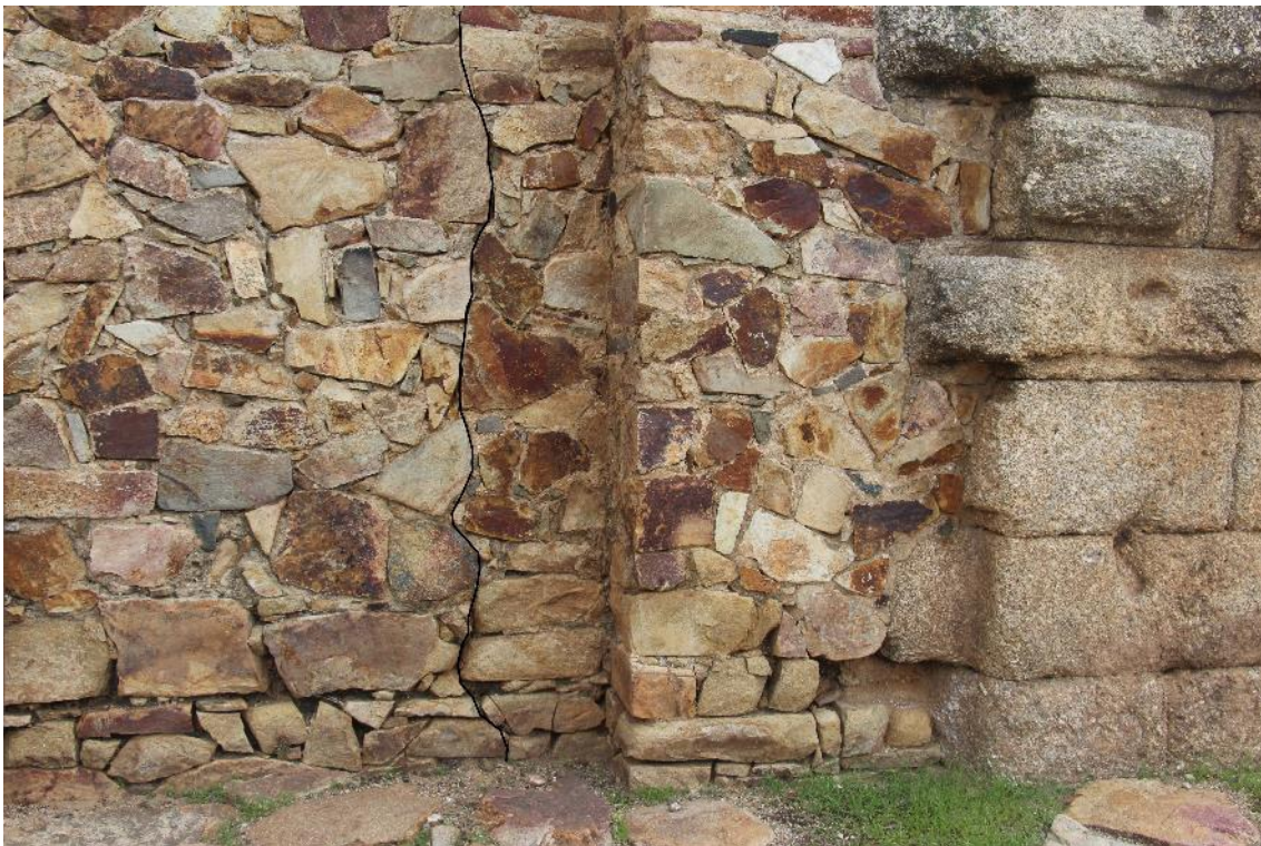
Fig. 11. Conexión entre pilastra y muro (autora).
