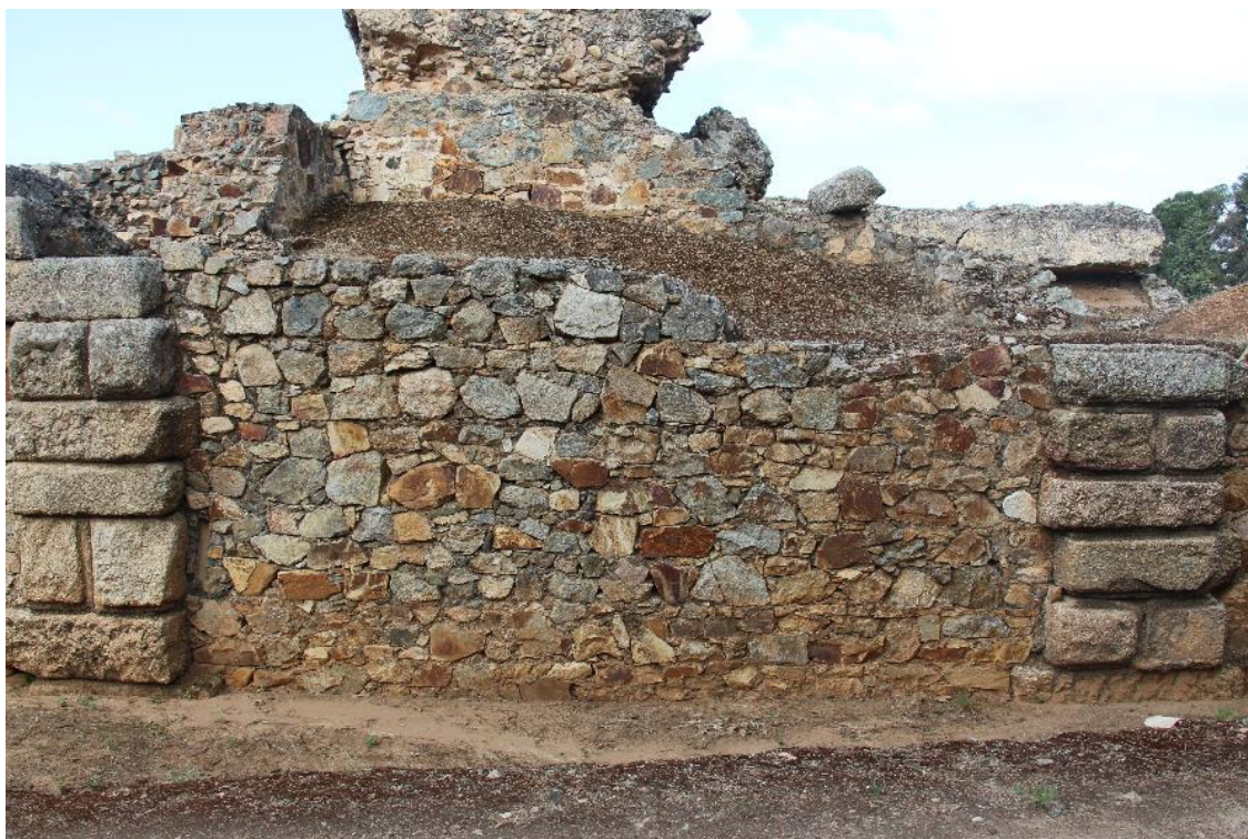
Fig. 27. Paramento sin pilastras en mampostería (Pa18) (autora).
