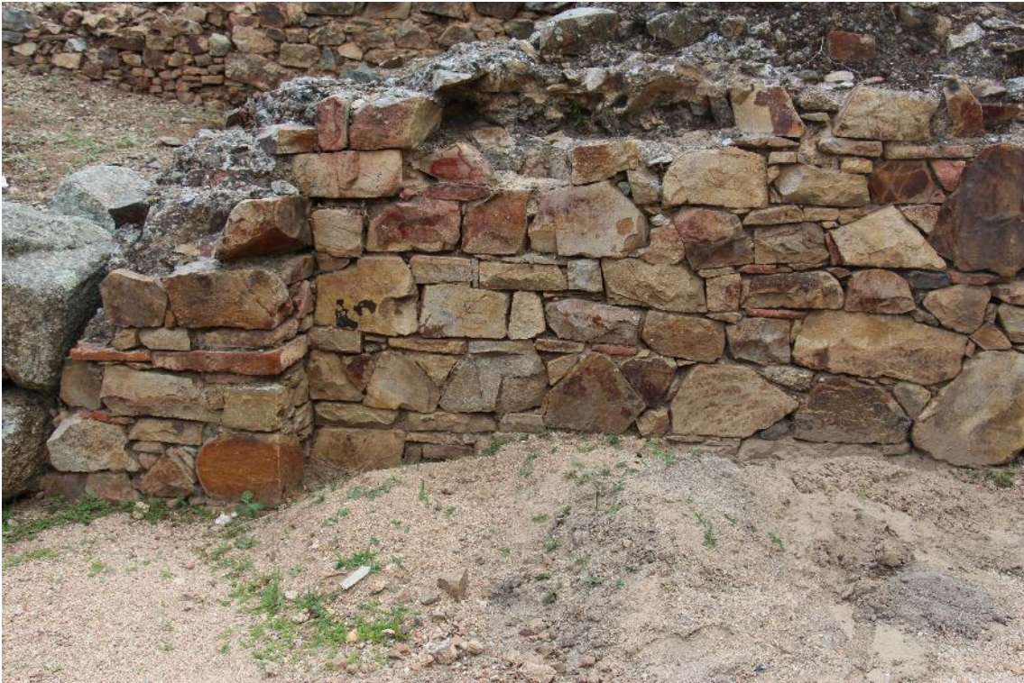
Fig. 59. Detalle de la regularidad de las tongadas en el tipo técnico-constructivo B (tramo 3) (autora).
