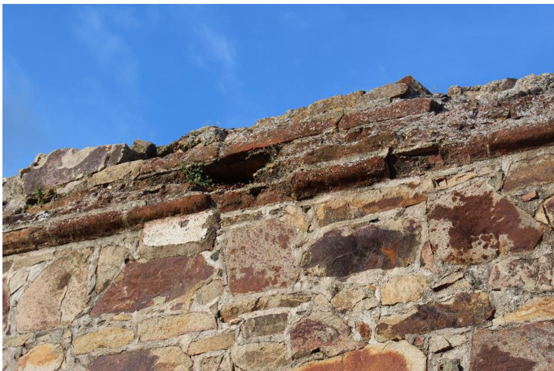
Fig. 49. Cornisa en ladrillo (autora).
