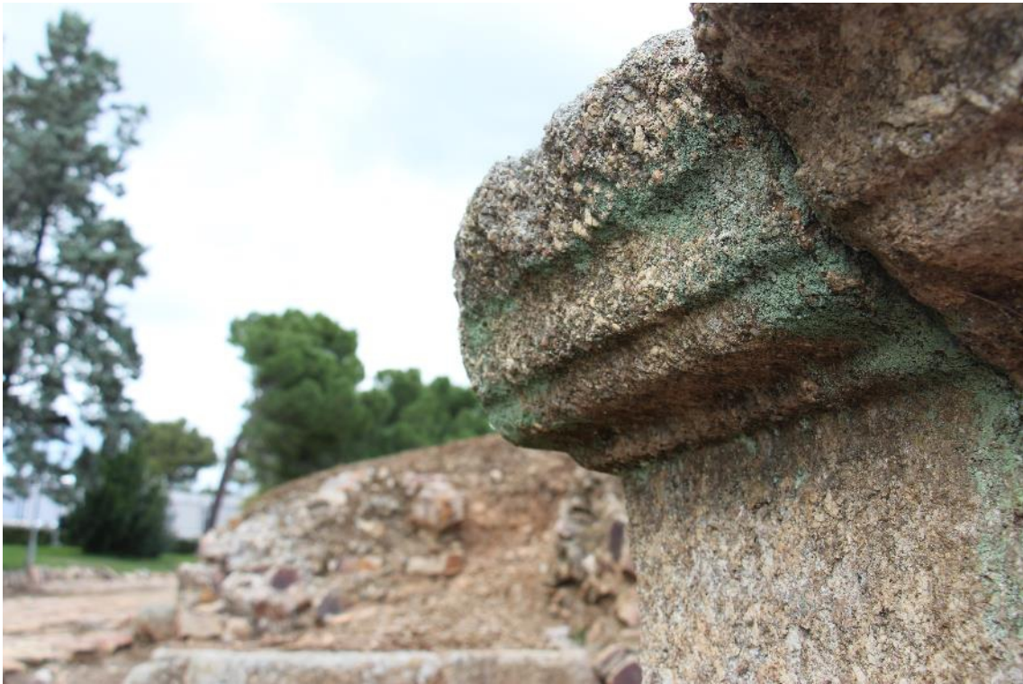
Fig. 55. Cornisa en la parte superior de la pilastra granítica P52 (tramo 13) (autora).
