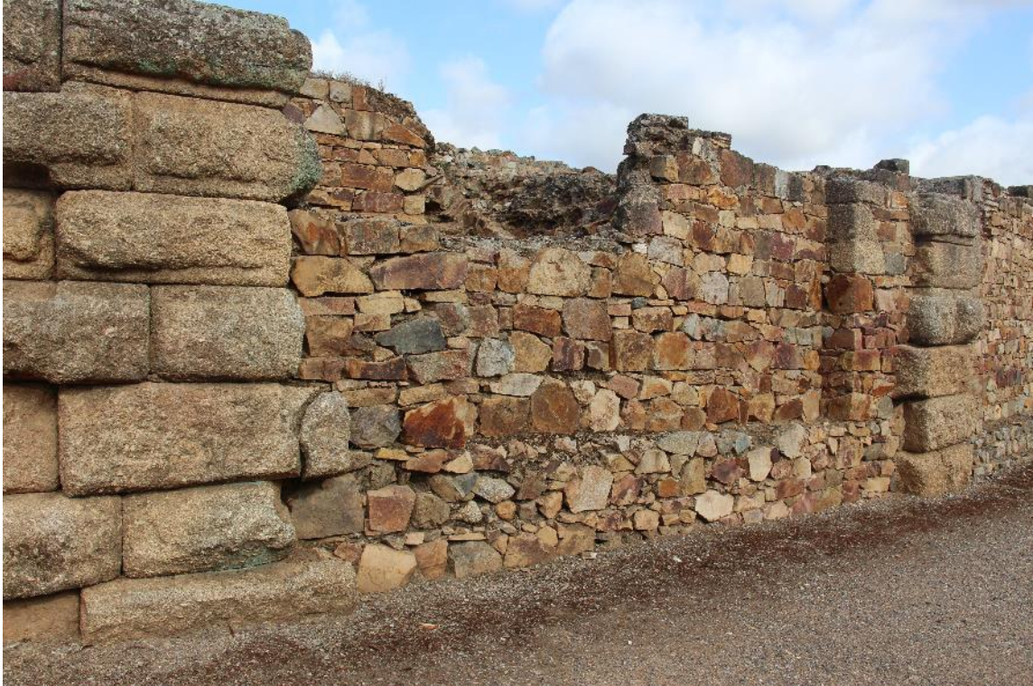
Fig. 25. Zócalo de cimentación en el Pa15 (autora).
