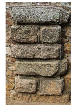
Tipo C. Modelo de pilastra con sillares pequeños y almohadillado anómalo
