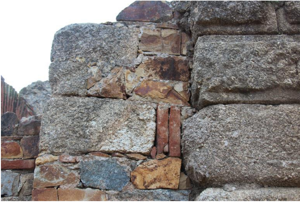
Fig. 47. Uso de ladrillo para completar la anchura de las pilastras en las soluciones de esquina (autora).
