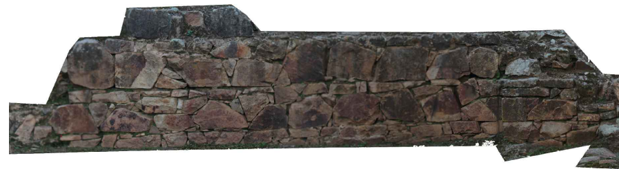
Tipo B. Modelo de paramento
