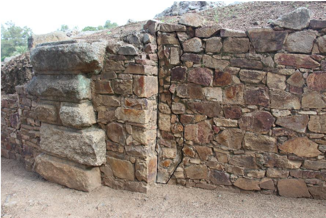
Fig. 14. Unidad estratigráfica de relleno entre el muro y la pilastra (autora).
