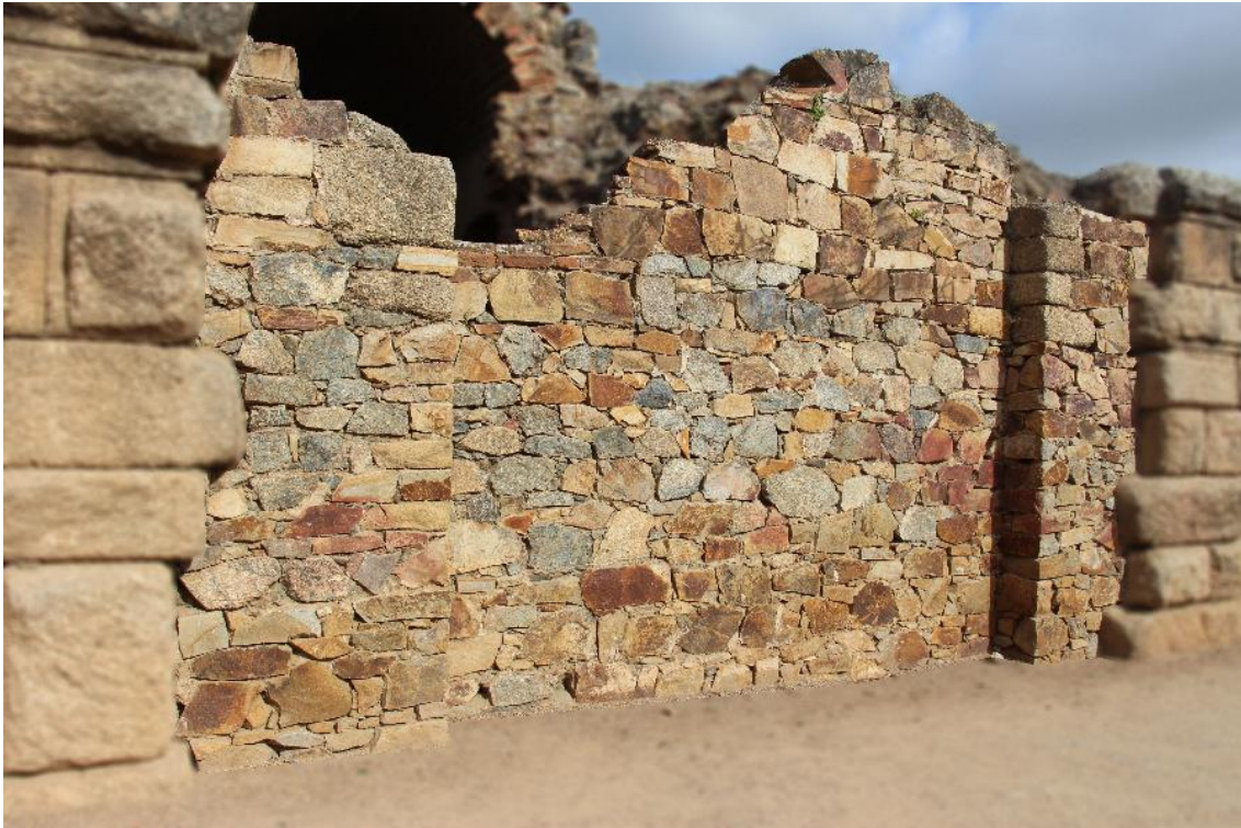
Fig. 10. Elementos constructivos en mampostería (autora).
