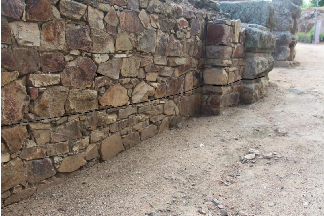
Fig. 22. Correlación entre la primera tongada de mampostería y la primera hilada de sillares en granito (autora).
