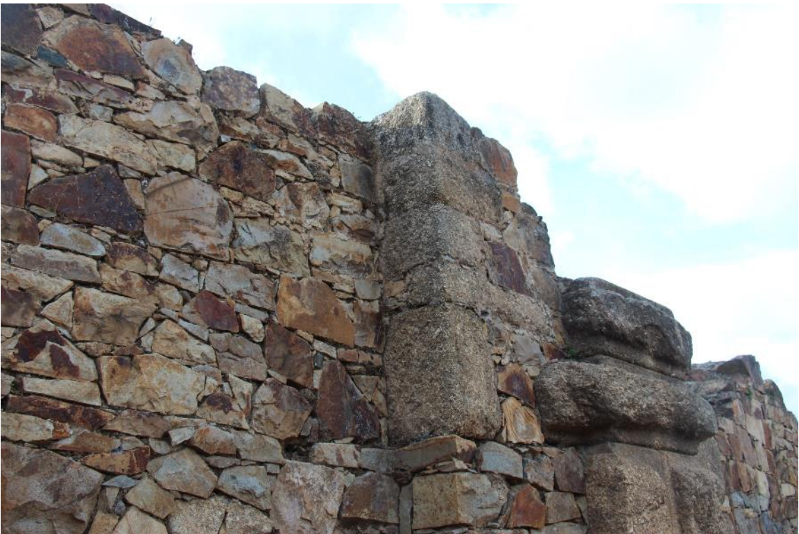
Fig. 46. Solución de esquina con sillarejos de granito (tramo 5) (autora).
