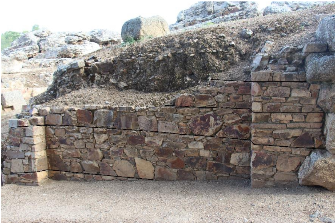
Fig. 42. Disposición de la mampostería en tongadas regulares (autora).
