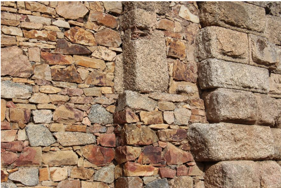
Fig. 52. Retranqueo de la pilastra en mampostería por debajo de los sillarejos de granito (autora).
