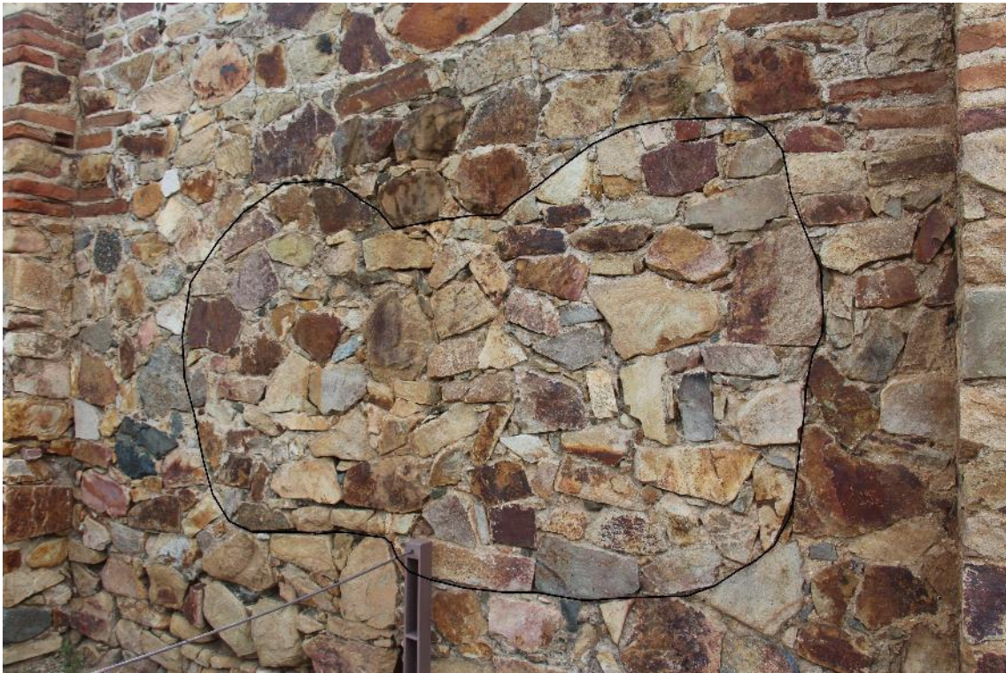
Fig. 13. Inclusión en mampostería en la parte central del Pa1 (autora).
