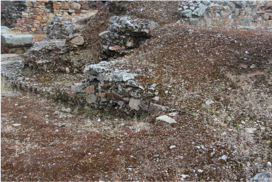
Fig. 44. Núcleo de hormigón del paramento que queda a la vista en la zona de contacto con la muralla (autora).
