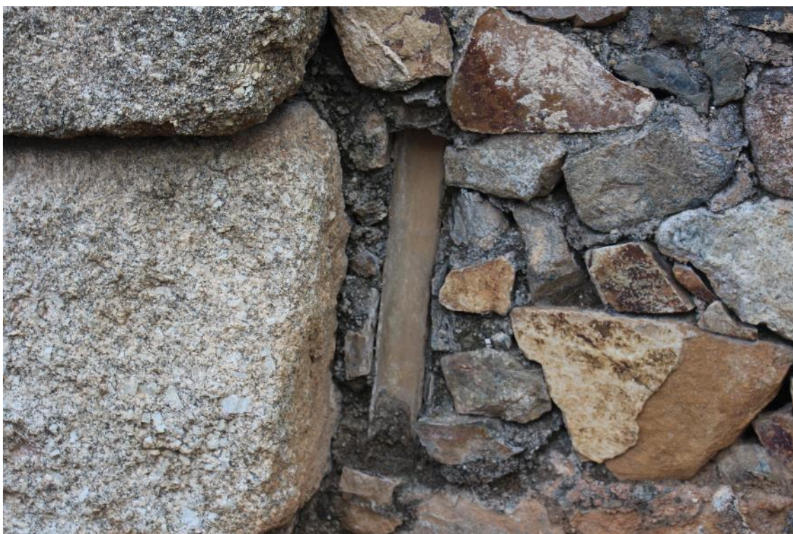
Fig. 19. Cañería moderna insertada en el paramento (tramo 7) (autora).
