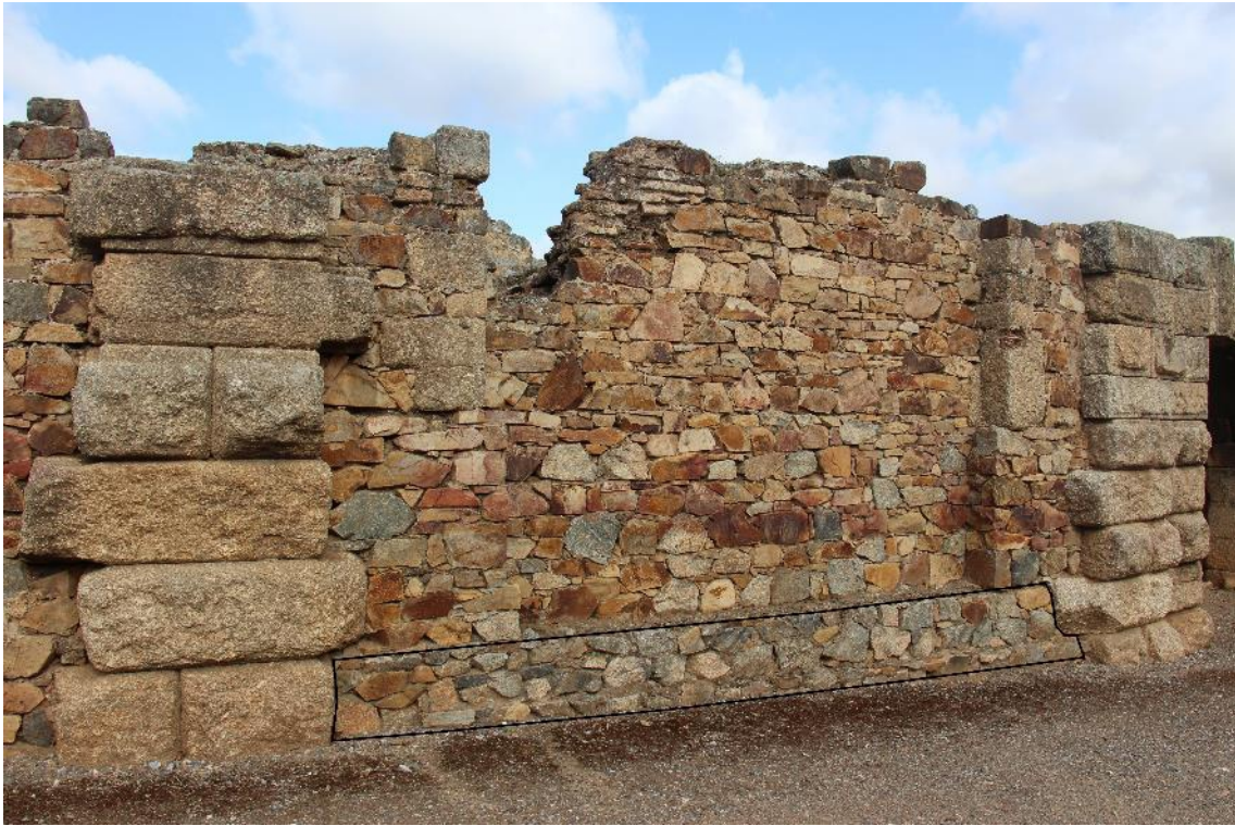
Fig. 12. Zócalo de cimentación en el Pa16 (autora).
