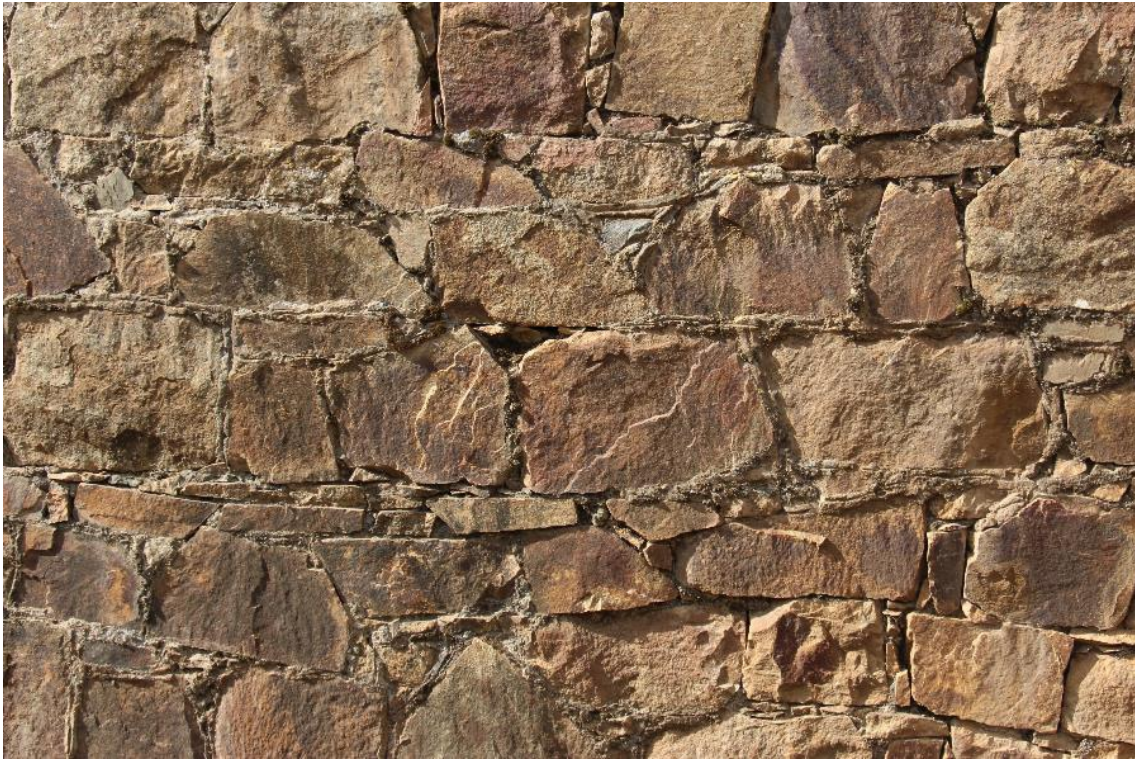
Fig. 57. Uso del mortero sobre las juntas entre mampuestos (tramo 9) (autora).
