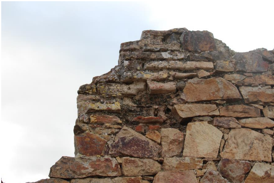
Fig. 15. Hiladas de ladrillo como marco de ventana (autora).
