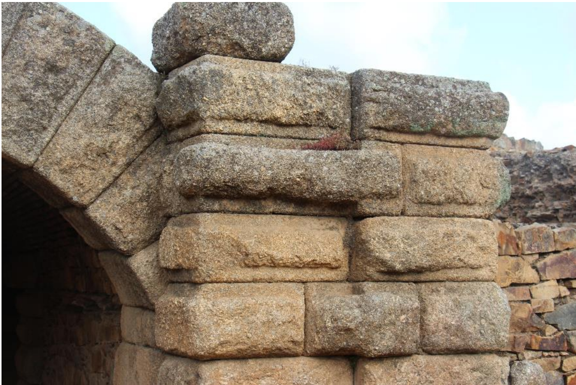
Fig. 53. Detalle del almohadillado de los sillares graníticos (autora).
