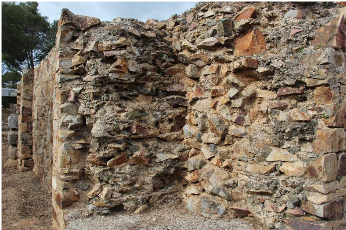
Fig. 39a. Núcleo del paramento externo (autora).
