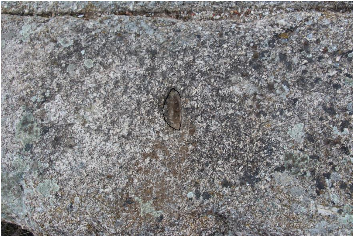
Fig. 34. Marca de palanca sobre un sillar (autora).
