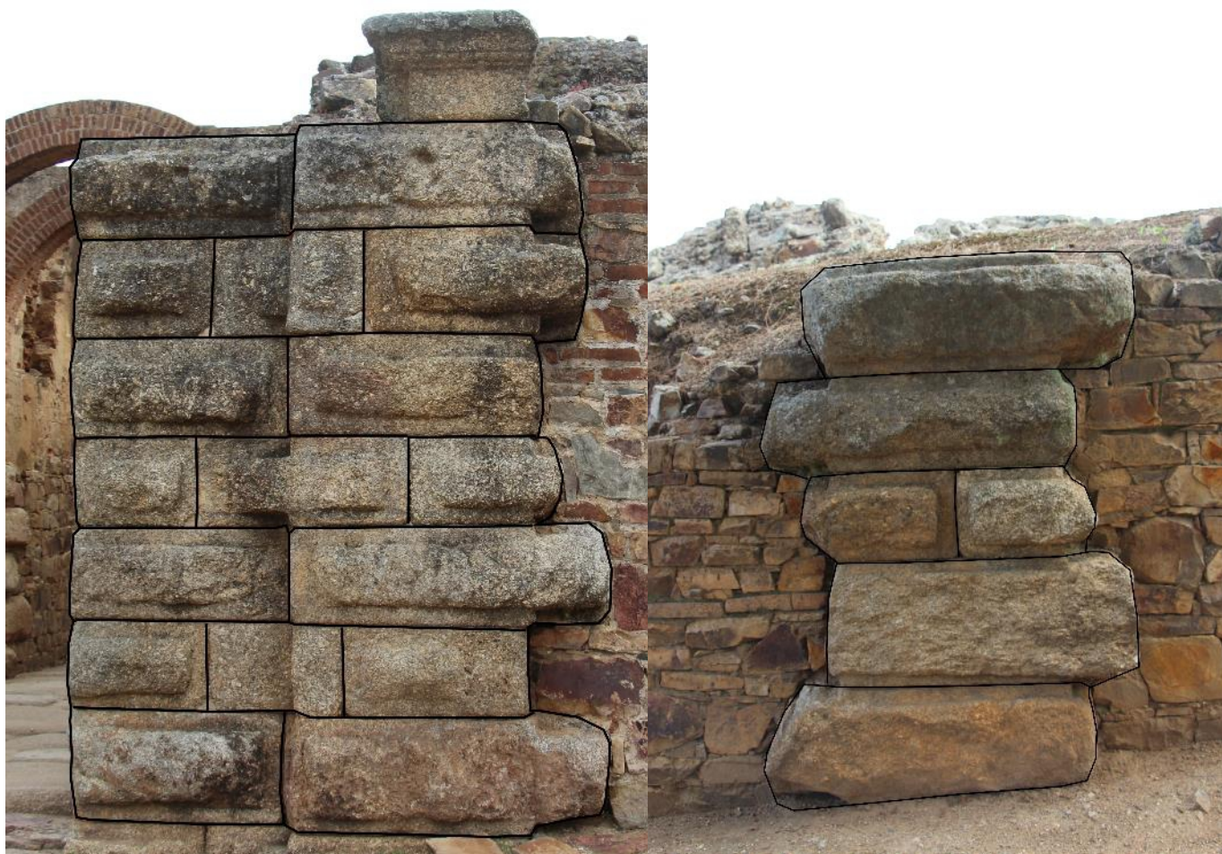
Fig. 28 y 29. Esquema constructivo estándar de las pilastras dobles (izquierda) y simples (derecha) (autora).
