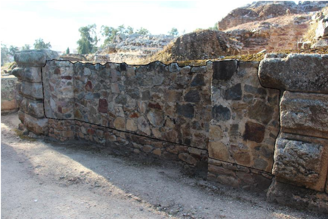
Fig. 20. Paramento reconstruido a mitad del siglo XX (tramo 4) (autora).
