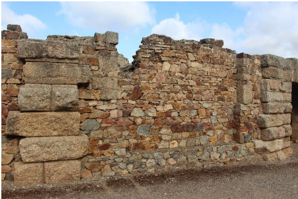
Fig. 26. Zócalo de cimentación en el Pa16 (autora).
