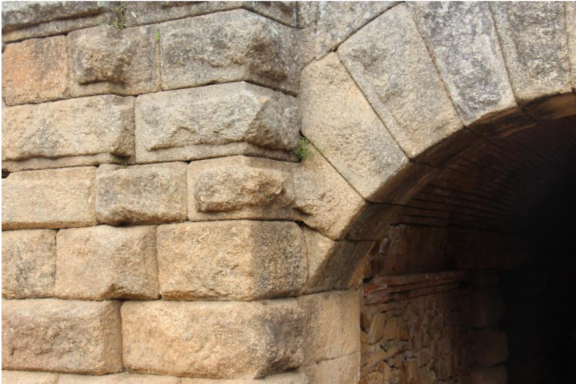
Fig. 16. Conexión entre la pilastra y las dovelas inferiores del arco del acceso 6 (autora).
