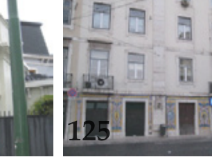
125 Fachada de azulejos
