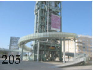
Intervenção torre SACOR, 1998 contemporânea, p. calapez (pavimento)
