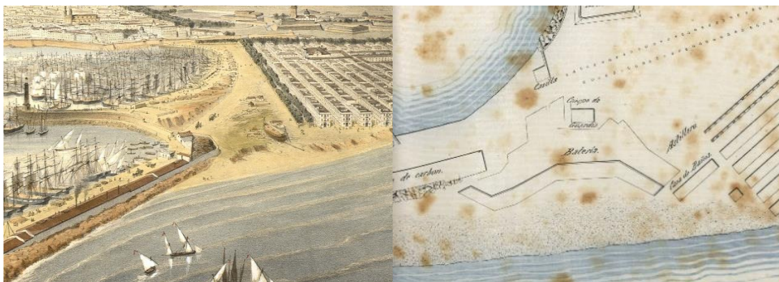
Imatge 2.4. - Detalls de l'espai de l'Astillero abans i després de la construcció dels Banys de l'Astillero i de la Bateria Reial (1856 i 1862)
