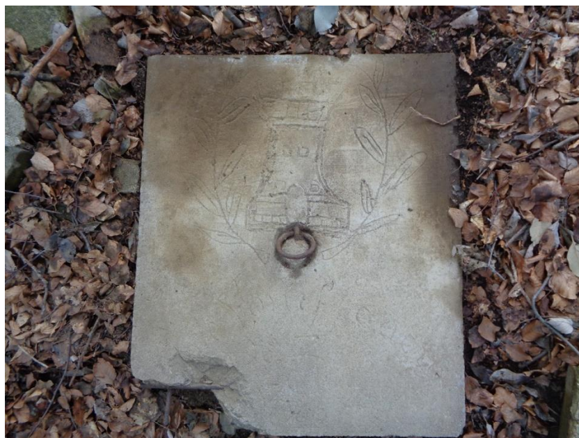
Fotografía 1. Tapa del pozo de registro grabada con el emblema de Ingenieros del Ejército y "Rgto Fortificaciones 3" sobre el cemento fresco. Fuente: autor. (Anexo 25)
