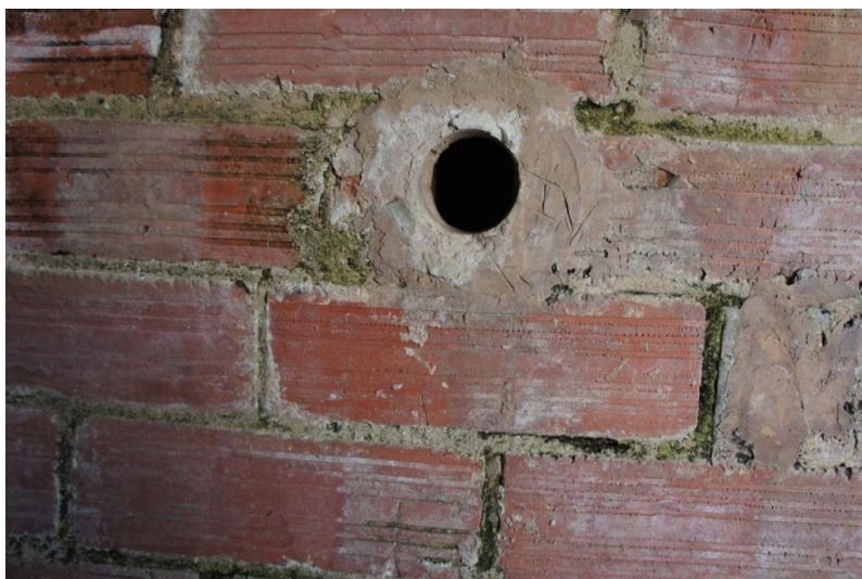
Fotografía 3. Detalle de uno de los respiraderos que garantizaban la ventilación de las habitaciones. Podemos observar un "IV" escrito en el cemento fresco, en clara alusión a la IVª Región Militar de Cataluña. Fuente: autor. (Anexo 31)
