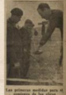
Los primeros medidas para el comienzo de las obras
