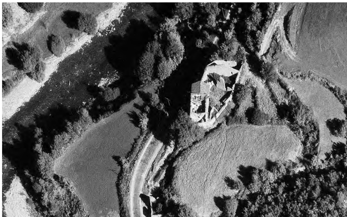
Imatge aèria de l'antic Hostal de Rei l'any 1967, al costat de la carretera C-13. Llavors, la construcció portava temps abandonada i, com veiem, es trobava en un avançat estat d'enrunament. (Foto cedida per l'ICC)
