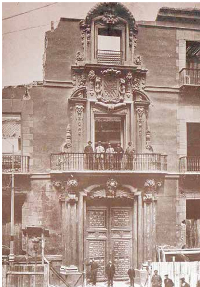
Fachada del palacio de los condes de Oñate en Madrid (c. 1915), Madrid, Fototeca del Instituto del Patrimonio Cultural de España, Fondo Ruiz Vernacci.
