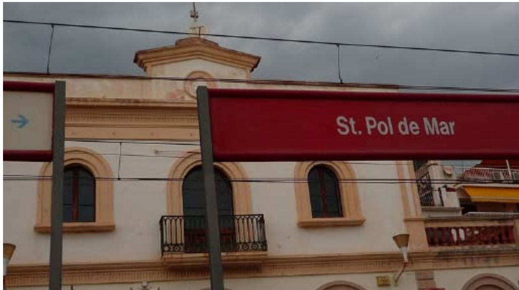
Estació de tren de Sant Pol de Mar
