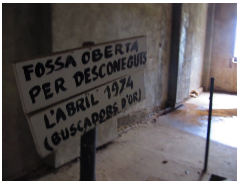
Imatge 3. Detall de l'interior de l'edifici operatiu de la Mina Canta. © Ferran Riera
