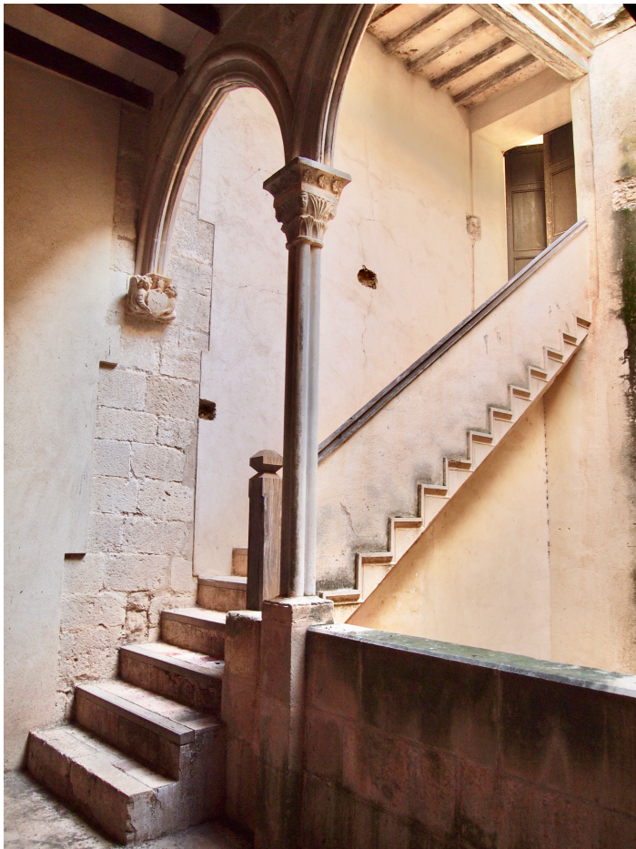
Escalera de acceso a planta tercera desde galería, sección 2
