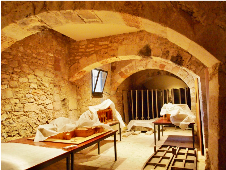
Sala de servicio, sección 2
