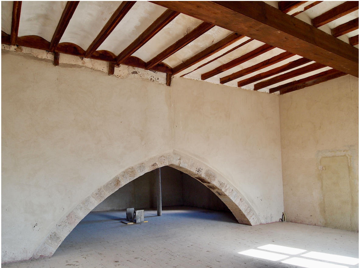
Fig.6 Sala noble de la planta primera con la parte superior del arco apuntado de la planta baja.
