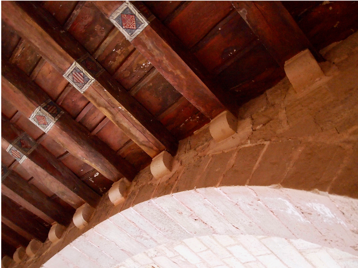
Fig.7 Artesonado policromado del vestíbulo del patio principal, las vigas reposan en modillones de piedra.
