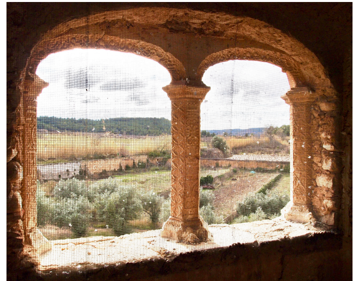
Vista sur desde la planta tercera con galería plateresca, sección 1
