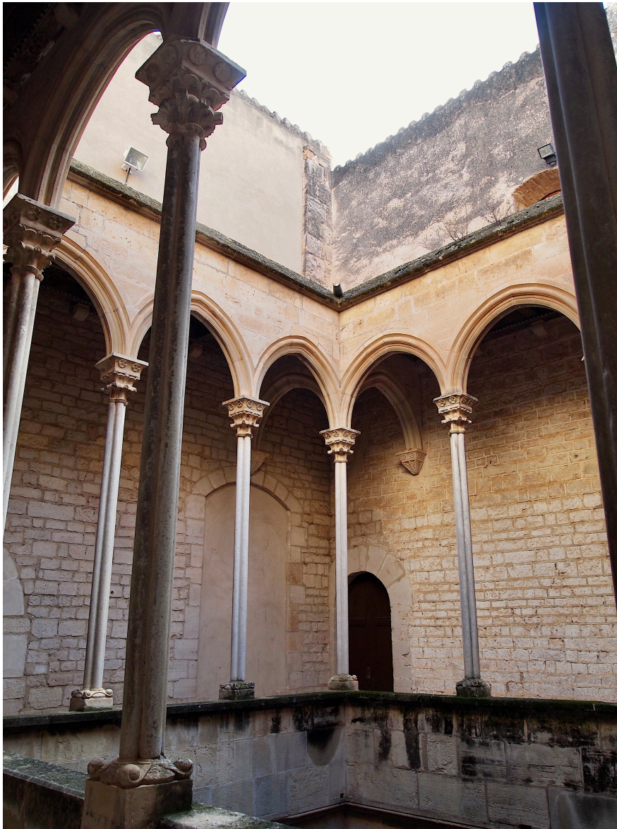
Fig.8 Galería de la primera planta con columnas cuadrilobuladas que sujetan la cubierta.
