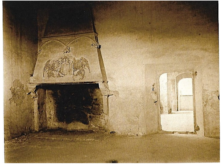
Sala noble con antigua chimenea, sección 2
