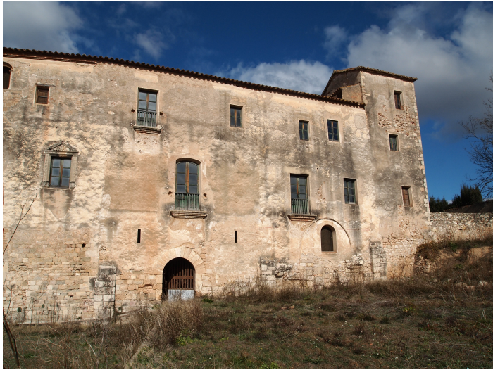
Fachada sur con acceso exterior, sección 2
