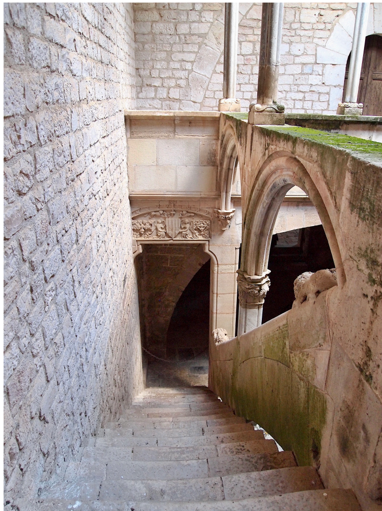
Fig.14 Lateral del patio principal con escalera hacia la planta baja y relieve con ángeles tenantes.
