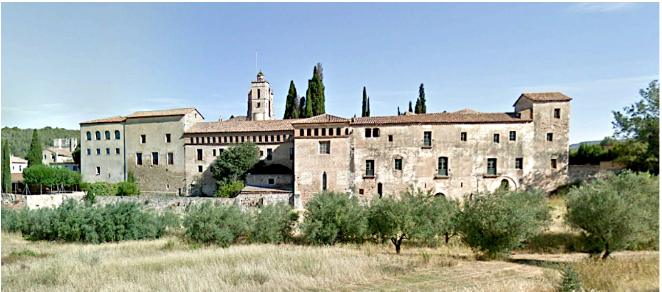
Fig.1 Monasterio de Santes Creus, vista de la fachada sur con el palacio situado a la derecha. Foto: Google Maps.
