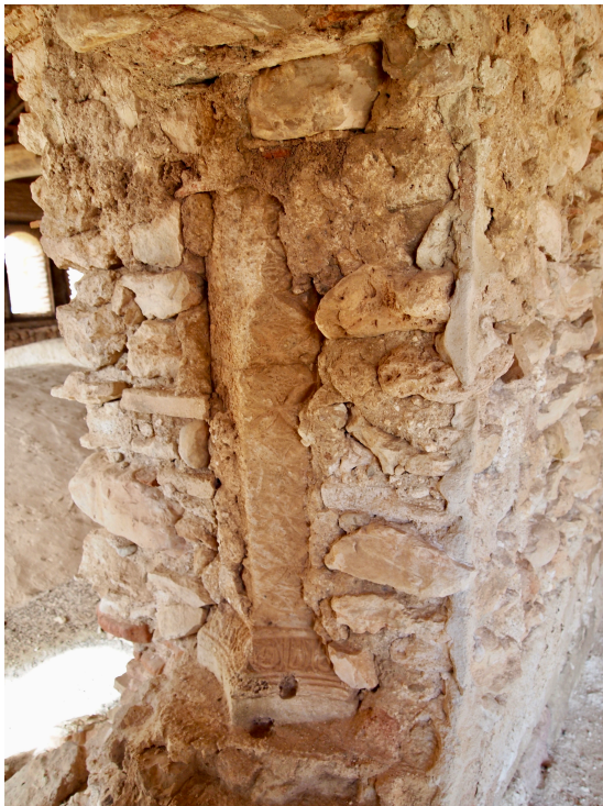
Restos de galería plateresca camuflados en muro planta tercera, sección 1
