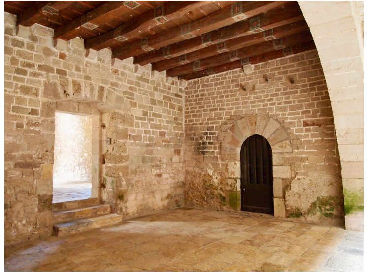
Vestíbulo patio principal, sección 1
