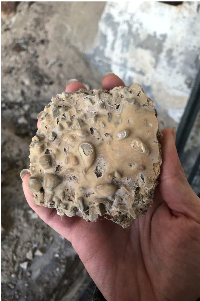
Fig. 10: Inici d'estalagmita, carbonat càlcic dissolt en aigua que aglomera grava. Museu del Ciment. Fotografia: Helena Ripoll
