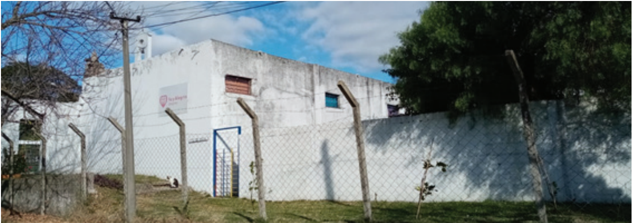
Imagen 9. Vista desde calle Millán del espacio que conecta el Patio de Primaria con el Patio de Infantil..
