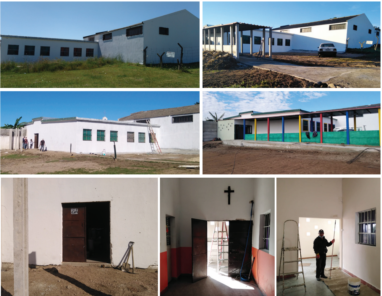
Imagen 11. Antes y después del acceso de Infantil. Proceso de obra.
