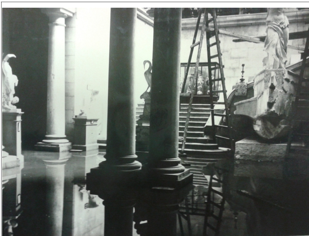
18. Inundació a les instal·lacions del Museu d'Art i Arqueologia. setembre 1915. Edifici de l'Arsenal. Arxiu Fotogràfic de Barcelona. clixé: 51842
