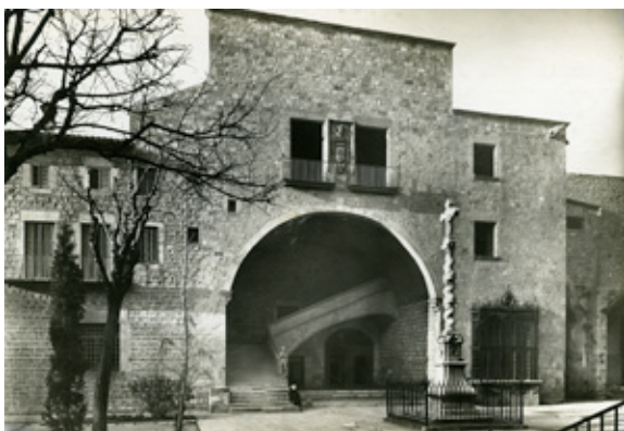
Vista Escaleras de acceso a la Nave Poniente (Año desconocido) Fuente: AFB
