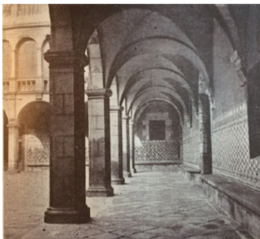
Vista Galeria del Patio. Casa de Convalecencia (1921) Fuente: Anuario del Hospital 1921
