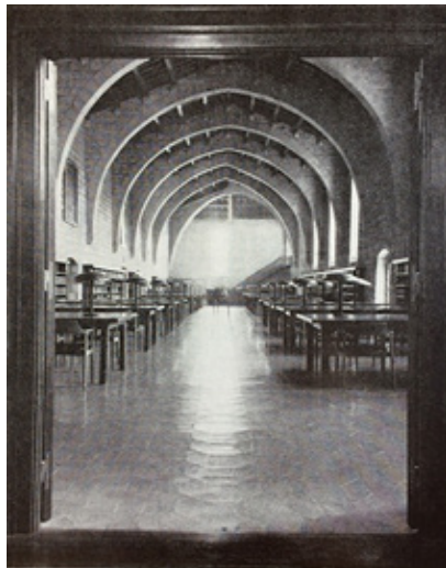
Vista nave gótica de levante (1921) Fuente: Anuario del Hospital 1921
