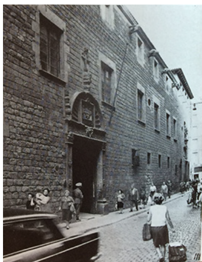
Vista entrada por Carrer Hospital (1921) Fuente: Anuario del Hospital 1921
