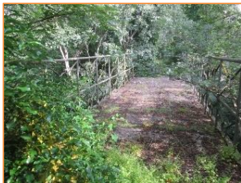
Accés a peu a les cases a través del pont
