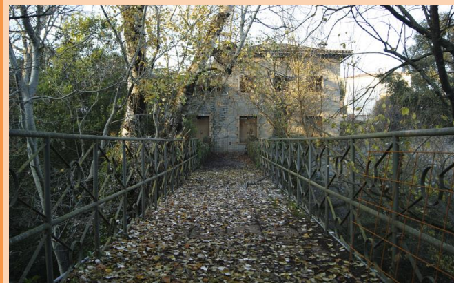
FOTOGRAFIA ACTUAL DEL PONT D'ENTRADA A LES CASES I A LA FÀBRICA. FONT: ELABORACIÓ PRÒPIA
