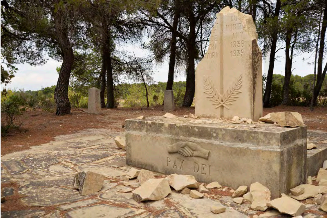
Fotografia 3.52. Vilalba dels Arcs, detall Conjunt memorial de Quatre Camins , projectat per la Germandat del Terç de Requetès de nostra Senyora de Montserrat entre l'any 1963 i 1968. Vandalitzat l'any 2018 encara continua en runes. Fotografia: autor
