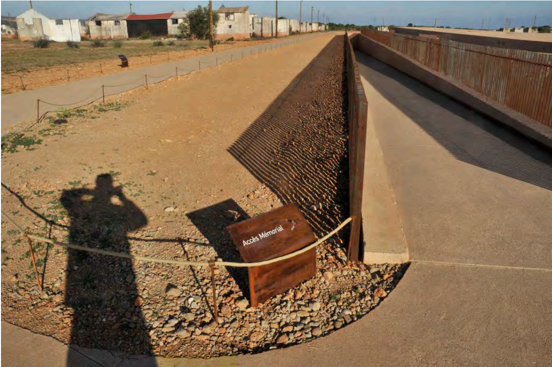
Fotografia 4.9. Accés a l'edifici del Mémorial du Camp de Rivesaltes . El Memorial dissenyat per l'arquitecte Rudy Ricciotti i inaugurat l'any 2015 ha preservat el vestigis del camp d'internament. Fotografia: autor
