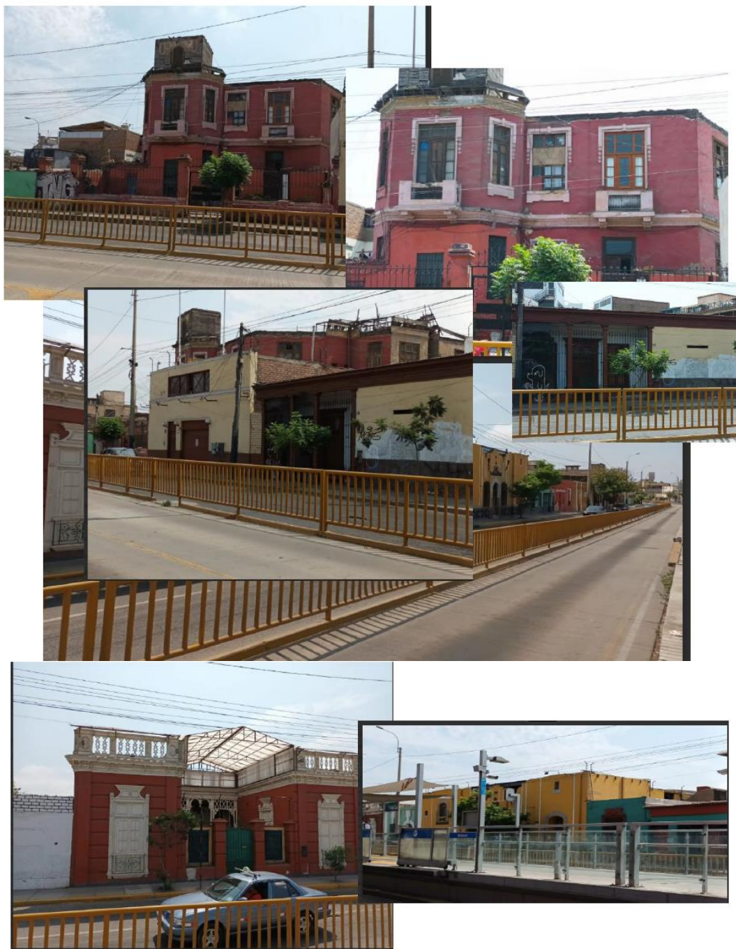
Figura 5. Fotografías de realización propia. Realizadas en la Avenida Bolognesi en 2023 donde se muestra la barrera del Metropolitano que separa en dos mitades la Zona Monumental.
