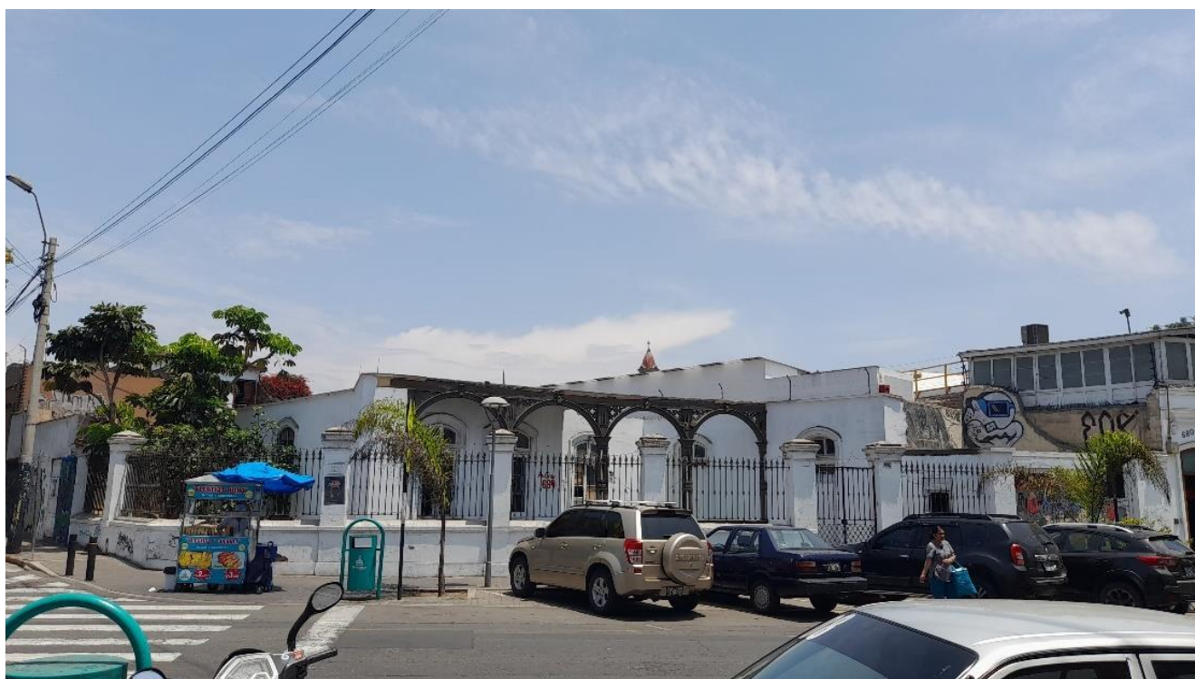
Figura 10: Fotografías de realización propia en la esquina de la Avenida Grau con Jirón San Antonio de una casona que estuvo a punto de desaparecer por abandono, la superior realizada en 2017 y la inferior en 2023.
