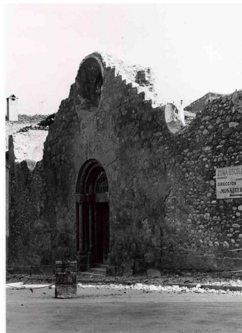
Imatges de les diferents fases d'intervenció dutes a terme a la façana entre 1965 i 1968 aproximadament. Des de la retirada del frontispici barroc fins l'aixecament quasi de nou de la façana actual
