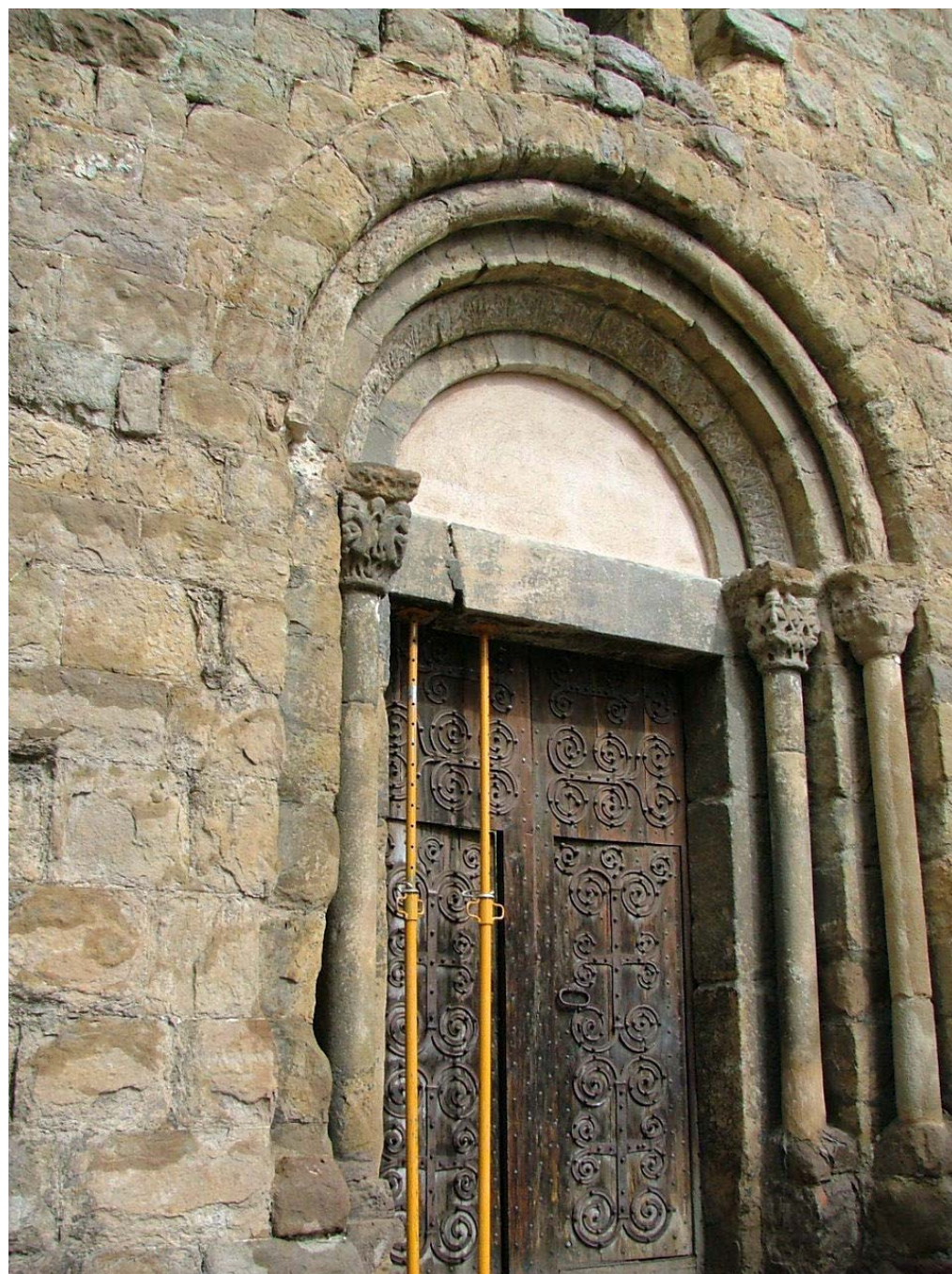
Actual aspecte de la portalada de Sant Pol. 2009
