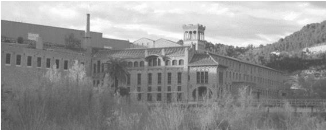
Fàbrica de la Bauma reformada amb la torre de l'amo en primer pla.
