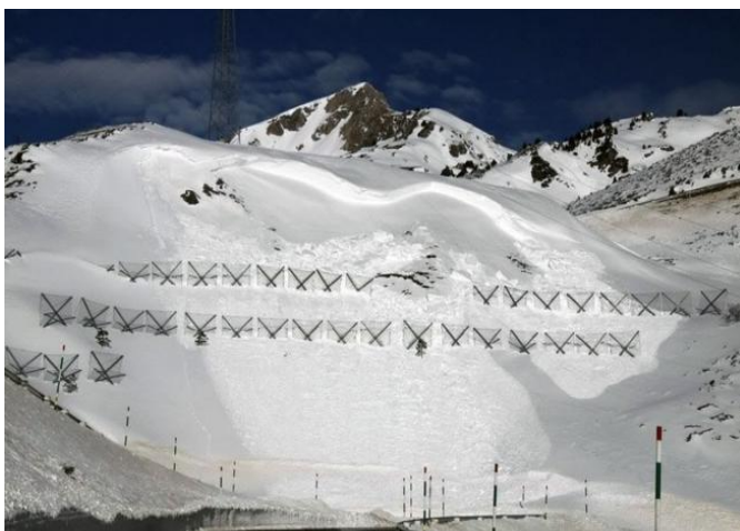
Fig. 2: Ejemplo de defensas activas permanentes en la rama sur de la carretera bajo el sector de Comials. Foto de: Centre Lauegi d'Aran, Conselh Generau d'Aran
