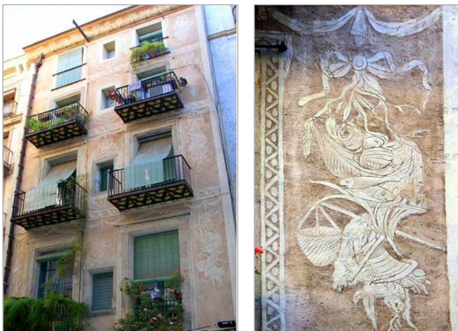
Fig.7 i 8. Façana de l'edifici d'habitatges del carrer de l'Hospital, 97 (1786). Mostra motius ornamentals habituals del barroc, com els corns de l'abundància Fotos autor
