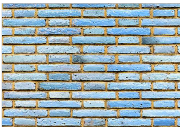
Fig.34. Detall de la façana de la Casa de la Lactància (n.c.102), on l’estucat d’imitació d’obra vista adopta uns cromatismes molt diferents al material al que emula. Foto autor
