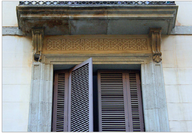
Fig.22. Llinda amb cinta esgrafiada. Edifici d'habitatges del c/d'Unió, 7 (ca.1875). Foto autor
