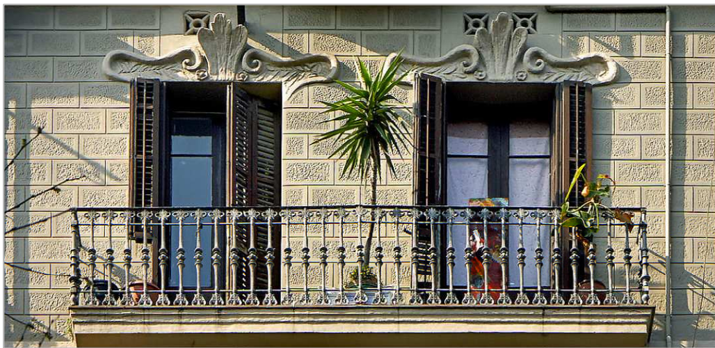
Fig.18. Parament revestit amb estuc d'imitació de carreus de pedra, amb un acabat desbastat. Casa Manuel Fransitorra (Isidre Reventós, mestre d'obres; 1890), al c/d'Aribau,79. Foto autor
