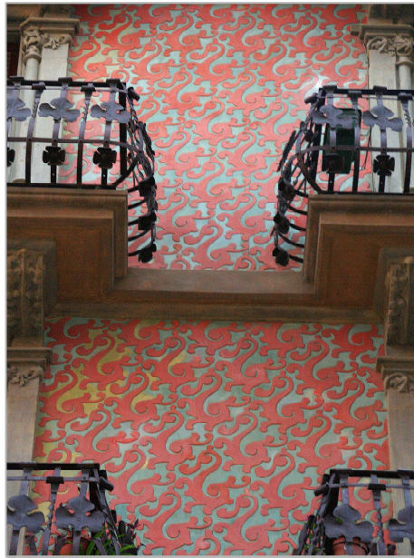
Fig.35. Esgrafiats que combinen un fons verd maragda, amb una superfície òxid de ferro vermell. Casa Jacinto Cardús 160 (Domènech Boada i Piera, arquitecte; 1902). Foto autor
