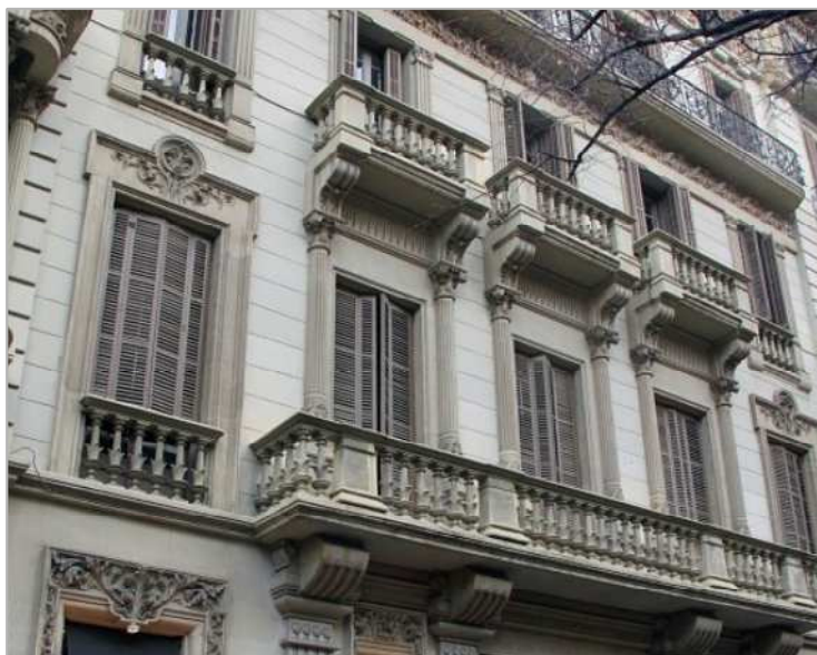
Fig.19. Façana revestida amb estuc d'imitació d'encoixinat, una opció d'acabat sempre lliscat. Casa Rodolf Juncadella 112 (Enric Sagnier Villavecchia, arq.; 1888-1890). Foto autor
