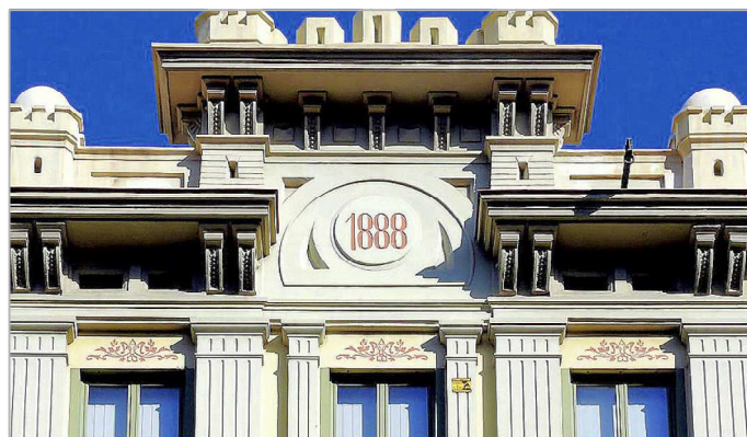
Fig.23. Façana de la Casa Ramon Reynés (Eudald Pagès, mestre d'obres; 1890) amb esgrafiament a les llindes i al coronament. Mostra una data que no s'escau amb la de l'acabament real. Foto autor
