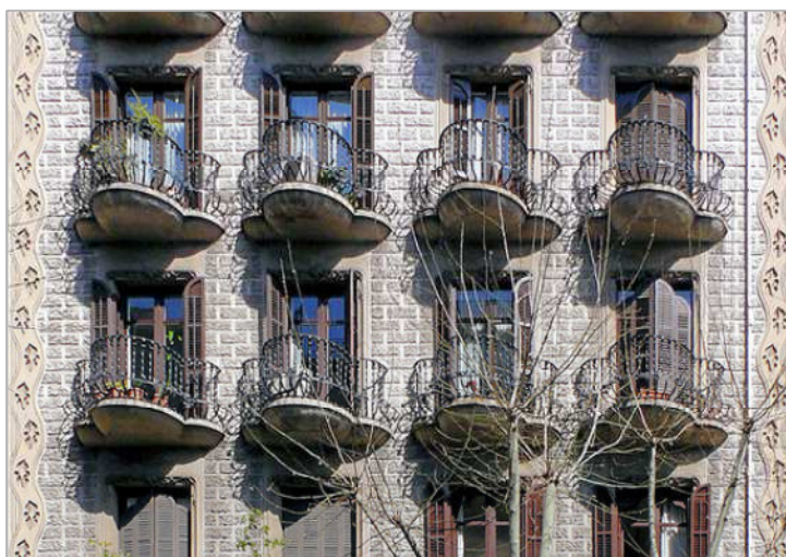
Fig.40. Cintes esgrafiades de contorn ondulant per marcar les mitgeres entre les finques contigües. Casa Francesc Cairó 186 (Domènech Boada i Piera, arquitecte; 1909-1910). Foto autor
