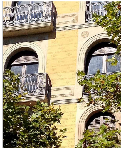
Fig.27. Façana de la Casa Dominica Juera (F. Batlle Felip, mestre d'obres; 1869), amb una disposició de cintes esgrafiades a lo llarg del parament. Foto autor
