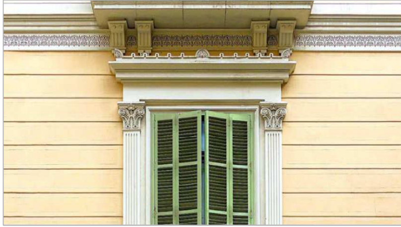
Fig.20. Façana amb cintes de sanefa esgrafiades als frisos. Edifici d'habitatges de la plaça de Regomir, 1 (ca.1870) 114 . Foto autor
