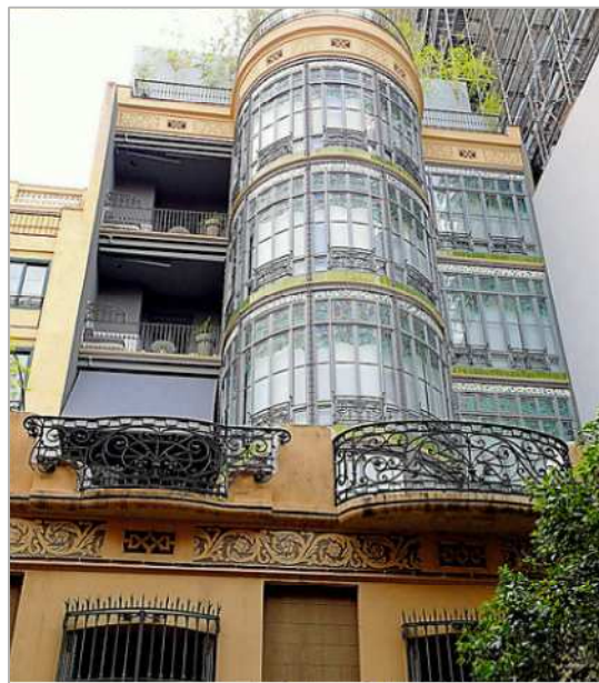
Fig.36. Façana posterior de la Casa Bonaventura Ferrer (Pere Flaqués i Urpí, arq.; 1905.1906), on s'hi aprecien frisos esgrafiats a la planta baixa i al coronament. Foto autor
