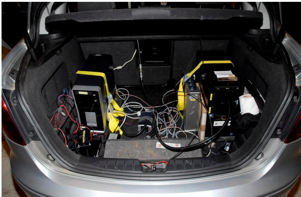
Figura 4-19. Sistemes instal·lats al portaequipatges per l'adquisició de dades.
