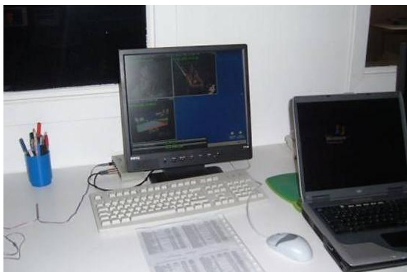
Figura 4-12. Vista de l'interior de la sala de control. Font: IBV.
