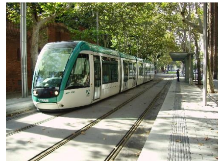
Ilustración 117. Accesibilidad en el TRAM. Fuente: http://www.tram.cat/es/galeria/
