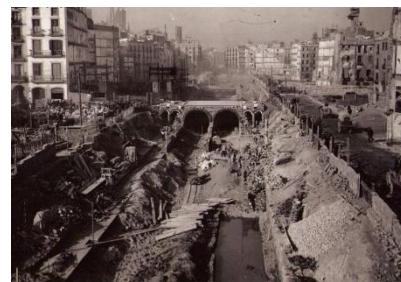
Ilustración 66. Obras de construcción del túnel de metro. 1912.
