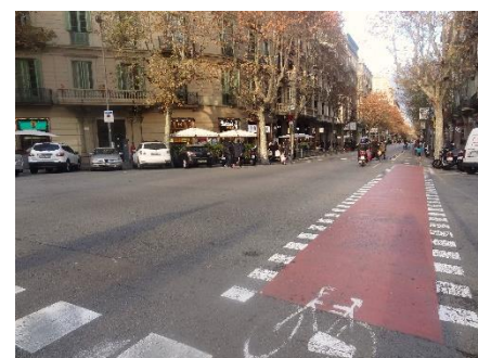
Ilustración 107. Señalización horizontal. Fuente: Fotografía de la autora. 2015.
