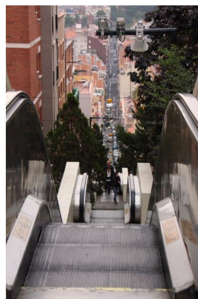
Ilustración 74. Escaleras eléctricas Vallcarça. Fuente: Fotografía de la autora. 2014.
