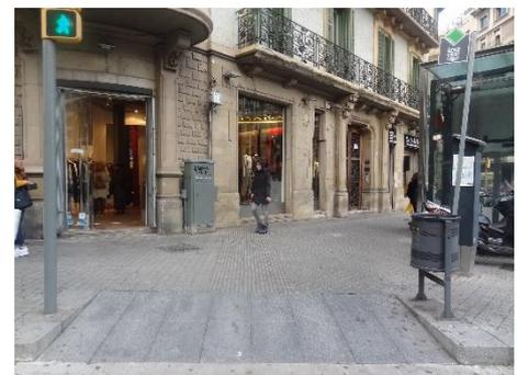
**Ilustración 140.** Pavimento Podotáctil con dirección a los cruces.
