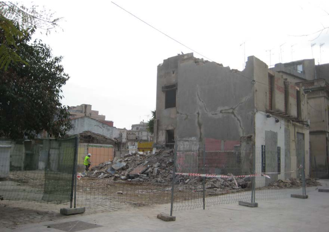
Enderrocs primera fase_ gener 2011
