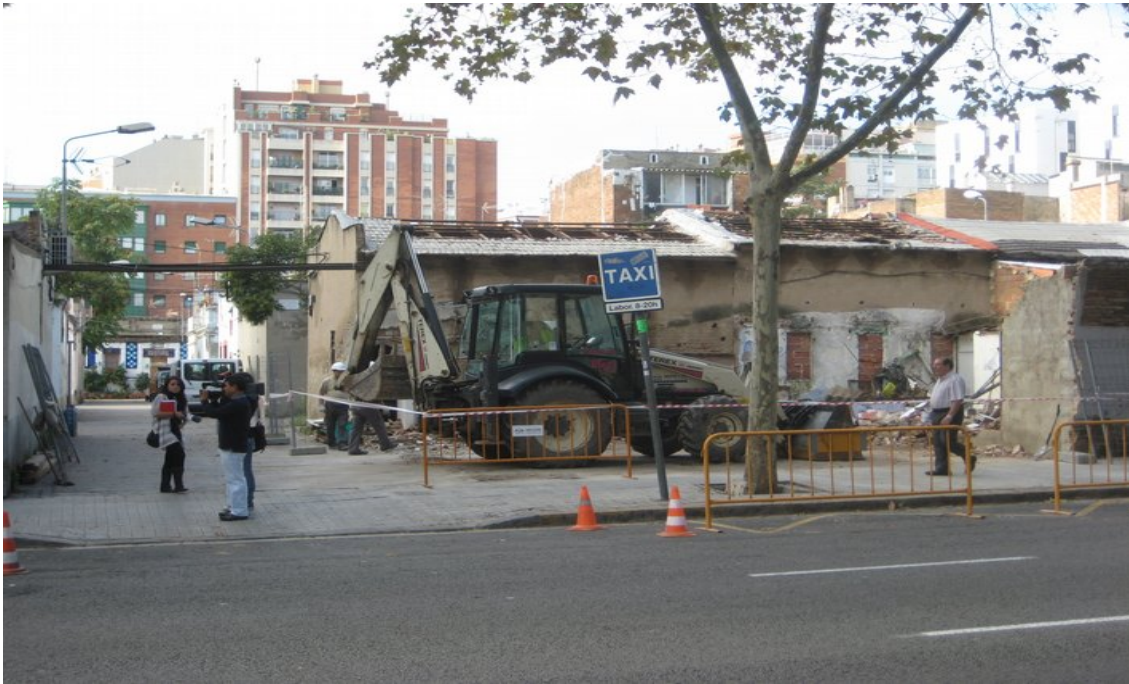
Primer enderroc_ octubre 2010_ Transversal amb Entença
