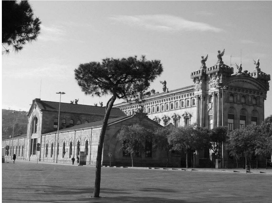
8. Nova Duana, visió posterior de l'edifici que permet veure la forma de H que adopta la planta
