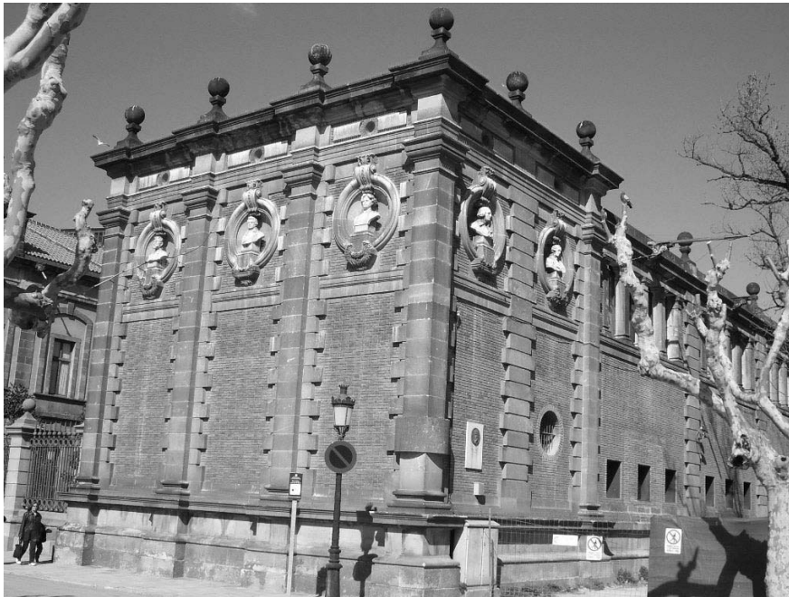
9. Un dels cossos afegits per Falqués a l'edifici de l'antic arsenal de la Ciutadella.
