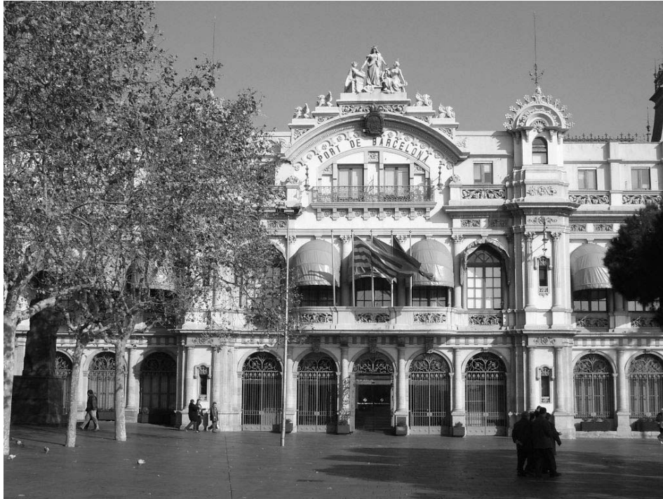
13. Detall de la façana principal de l'Antiga Estació Marítima del Port de Barcelona. S'observa la remunta sobre la planta principal.
