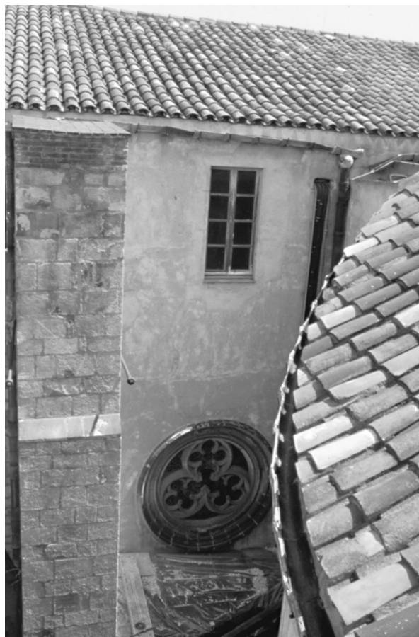
Exterior del Saló de Cent, contrafort del costat oest (Foto E. Riu).
