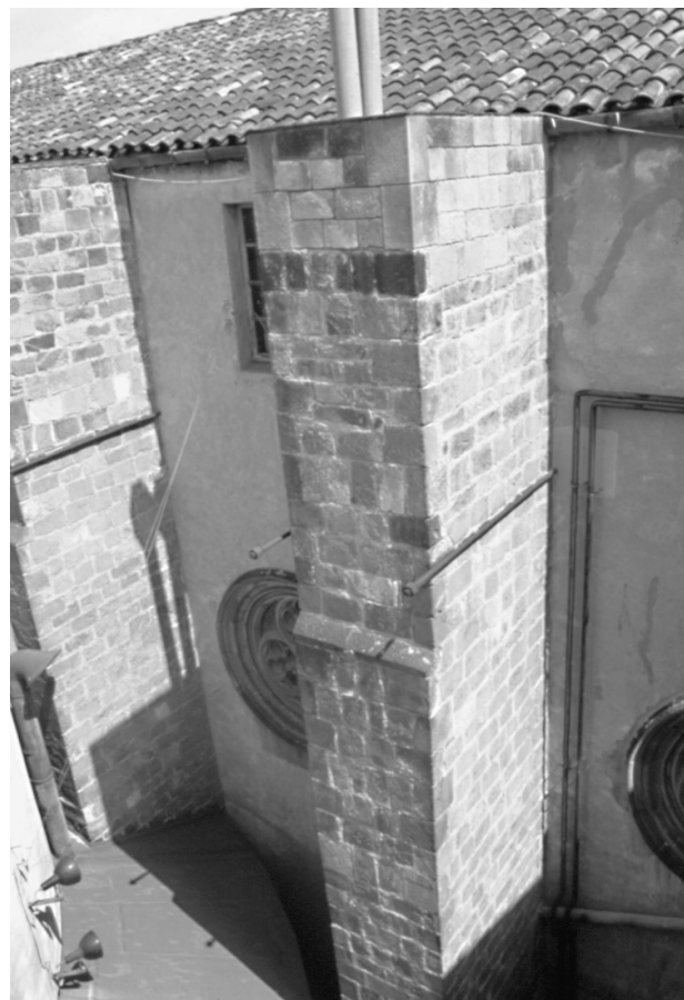
Exterior del Saló de Cent, darrer contrafort del costat oest, a l'extrem sud (Foto E. Riu).
