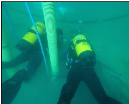
Fig. 11. Fotografia de la mànega de succió d'aire. Imatge del CASC.
