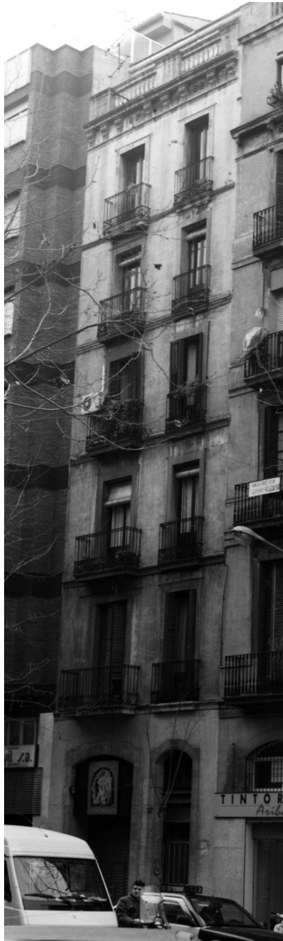
7. Casa Torrents, construida por el maestro de obras L. de Miguel i Roca.
