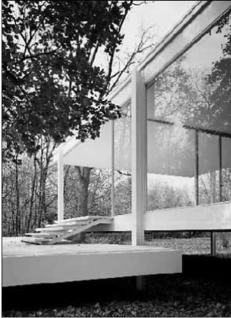
Casa Farnsworth. Mies van der Rohe, Chicago, 1951. La transparencia como símbolo de la modernidad arquitectónica
