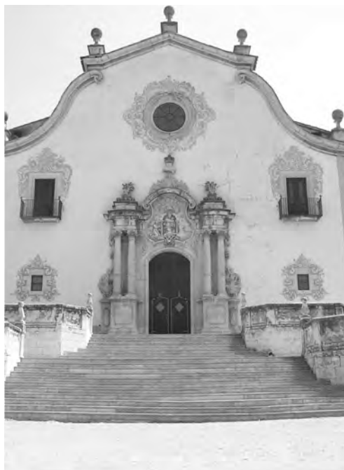
Figura 3. Façana de l'església del Santuari de Santa Maria de la Gleva. Projectada i construïda per Josep Morató Sellés entre 1759 i 1766.
