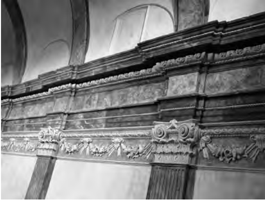
Figura 4. Fotografia del mur sud un cop finalitzats els treballs. Amb la descoberta de la pintura i amb l'execució de tractaments de conservació-restauració, s'ha recuperat l'ornamentació original de la capella.
