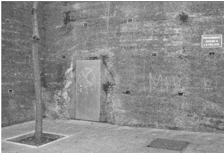
Fotografía 3. Puerta metálica que da acceso al refugio de Can Peguera, en la actualidad cerrado al público, sito en la calle Cornudella, en el distrito de Nou Barris.
