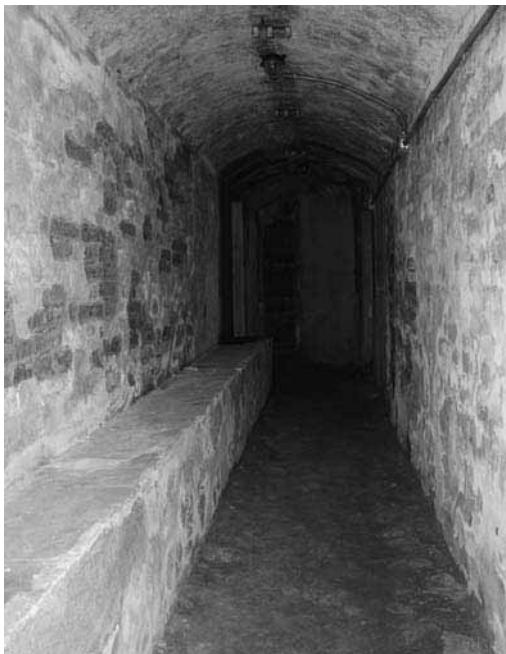
Fotografía 8. Pasillo y banco continuo de piedra en el interior del refugio de la plaza de la Revolució.
