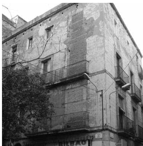
Fotografía 1. Estado actual de uno de los edificios alcanzado por los obuses disparados en la noche del 13 de febrero de 1937 desde el Eugenio di Savoia. Se encuentra en la confluencia de las calles Perill y Venus, en el barrio de Gràcia.
