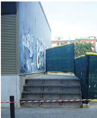
Escaleras plataforma, fachada posterior.
