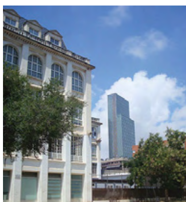
F. 56b. Fachada actual Can Felipa.
