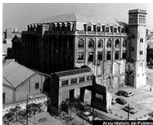
Figura 33. Fachada nave central Camí Antic de València, 1981. Edificio en proceso de rehabilitación.
