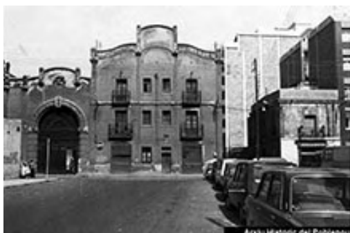
F. 28a. Acceso antes de ser derruido.
