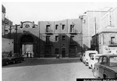
F. 28b. Inicio del derrocamiento de la edificación que impedía la prolongación de la calle Peralada, 1975.
