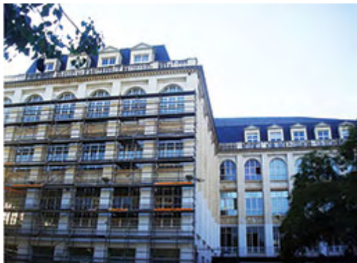
F 40b. Fachada en proceso de rehabilitación.
