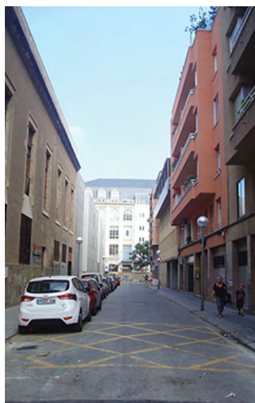
F. 89b. Fachada 2017.
