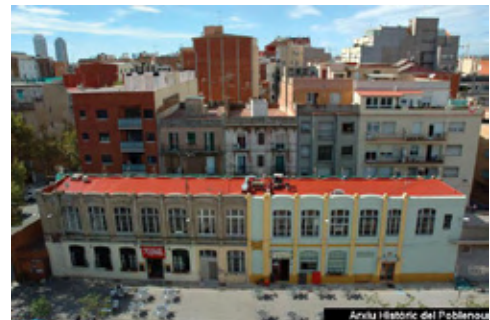
F. 77b. Fachada 2006.
