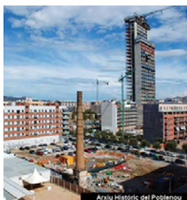
F. 56a. Construcción Hotel Habitat Sky, 2006.
