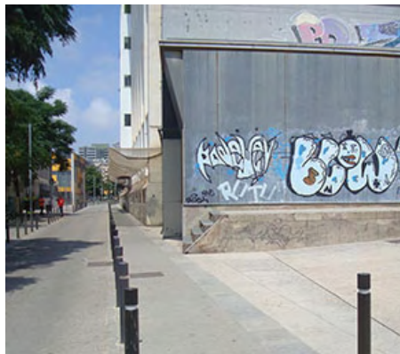
Fachada posterior lateral.
