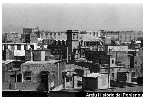
F. 55a: Los edificios cercanos apenas superan la altura de Can Felipa, 1981?.
