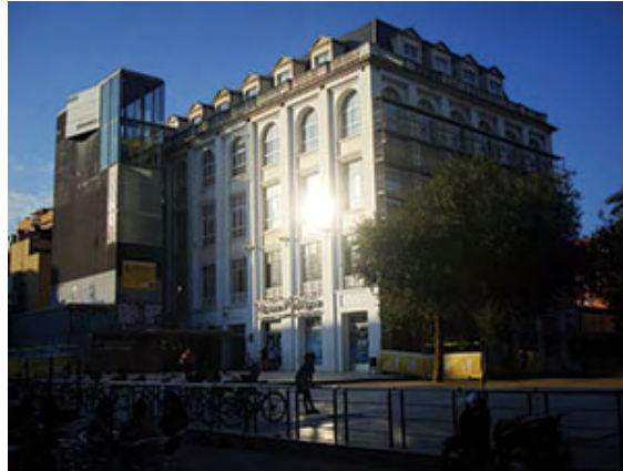
Figura 19. Centro Cívico Can Felipa. Fachada en proceso de rehabilitación, septiembre de 2017.
