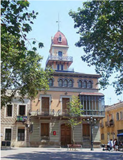
Figura 3. Estado actual de Can Deu y de las Cotxeres de Sants. 2017.
