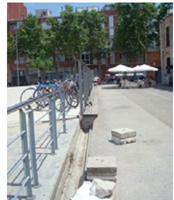
Escalera, fachada lateral.
