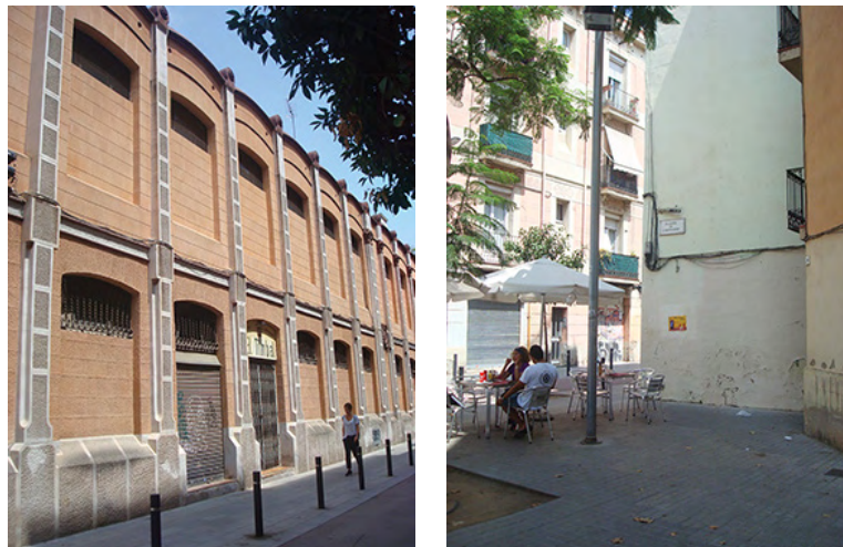
Figura 88. Fachada comedores y plaza L'Arengader.
