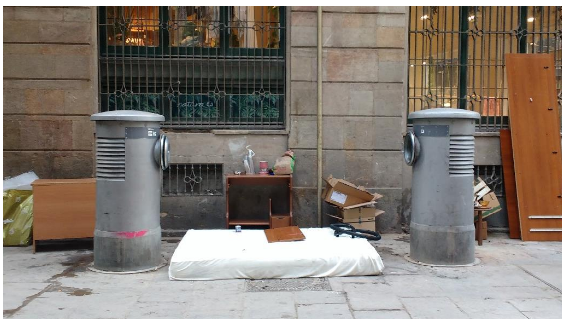
33. Buzones de recogida neumática en carrer de Abaixadors / Fuente CGSH
