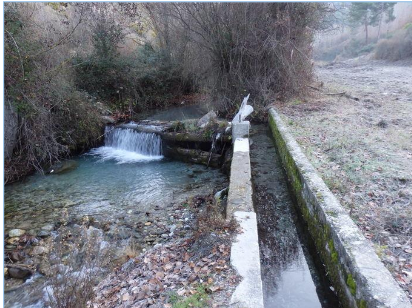
Figura 18 - Exemple del sistema de captació d'aigua d'una séquia al riu Dílar a Andalusia, amb la presa construïda a partir de troncs i grans blocs de pedra.
