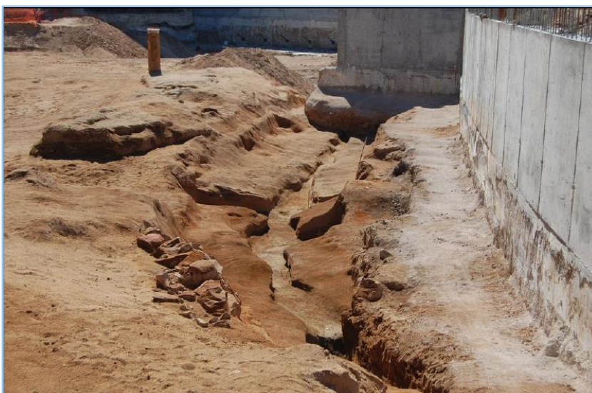
Figura 55 - Fotografia de la desviació provisional de la cuneta del RC, un cop excavada. Font: Soberón, 2014.
