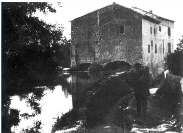
Figura 23 - Exemple d'un casal de molí fariner situat directament a sobre un rec, a l'Alt Camp. En primer terme es troba la séquia, l'aigua de la qual s'introdueix dins l'espai del carcabà a través de les arcades de la façana, i generant energia hidràulica gràcies al salt d'aigua. Font: Rius, 1994.
