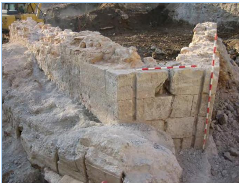
Figura 46 - Estructura en forma de V que hauria servit com a encaix de les comportes. Al vèrtex s'hi observen clarament les guies per a les comportes. Font: Santanach, 2007.
