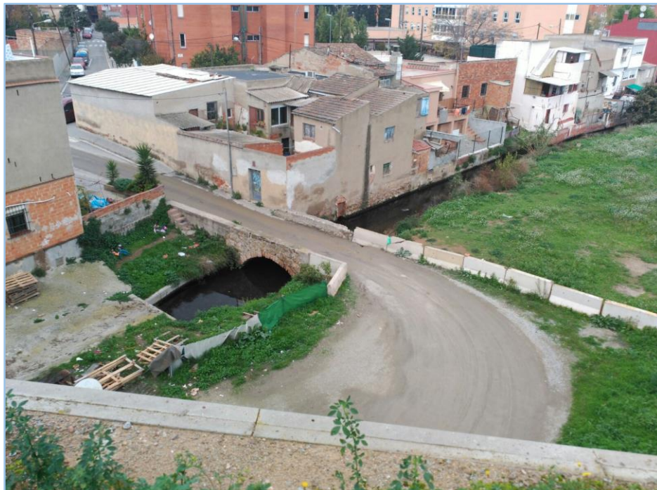
Figura 12 - Imatge general del pas del Rec Comtal a tocar de les façanes i sota el Pont de la Vaca, des del sud-est. Font: pròpia.
