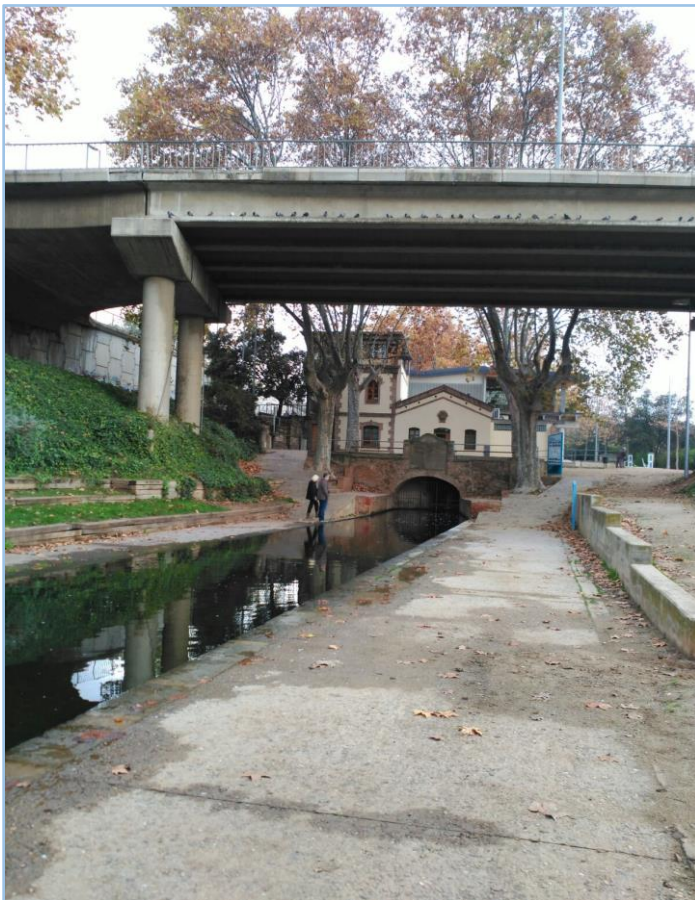
Figura 3 - Vista del canal des del sud-oest. Al fons es veu el punt de sortida de les aigües a la superfície. A sobre, el Pont de la Mina. Font: pròpia.
