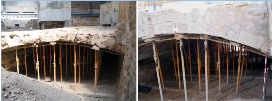
Figura 31 - Cares nord i sud del pont de la Carnisseria durant les tasques d'excavació l'any 2006. Font: Fernández, Hinojo, 2006.
