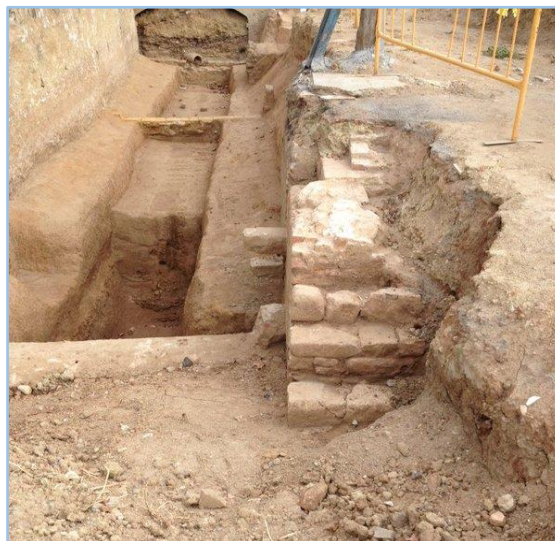
Figura 33 - Escales excavades a la intervenció del carrer Dos de Maig, a tocar la Plaça de les Glòries Catalanes, amb el tram del Rec Comtal al fons.
