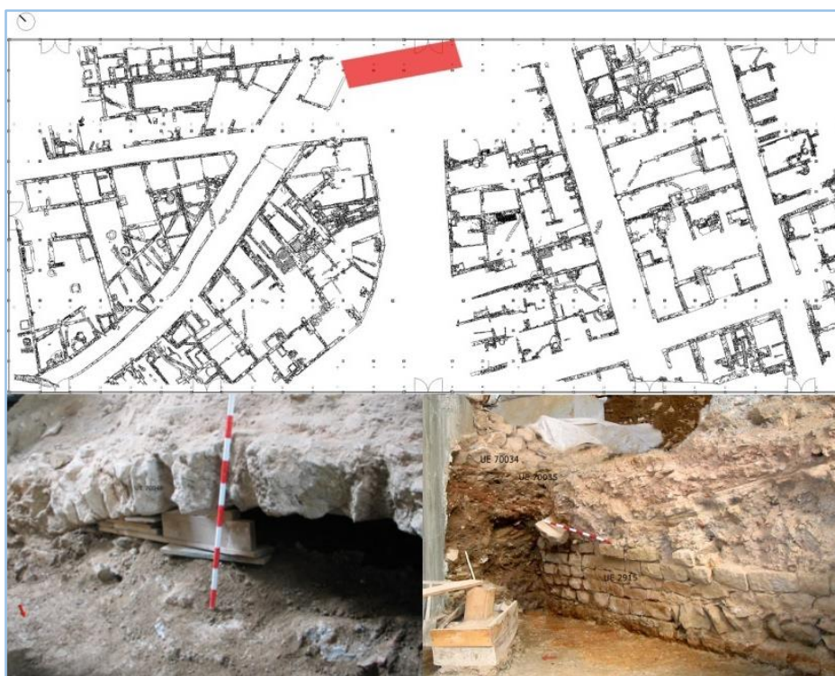
Figura 49 - A dalt, zona on es va dur a terme el desviament. A baix a l'esquerra: volta del Merdançar parcialment seccionada. A la dreta: detall del mur del RC en el punt on es va produir el desviament. Font: Fernández, Hinojo, 2006.
