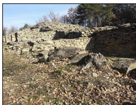
Figura 24: A la part esquerra de l'estructura hi ha una gran presència de sòcols d'arbre entre els murs. (Fotografia pròpia)
