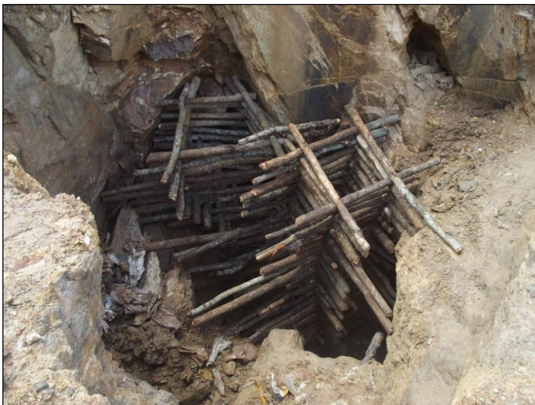
Figura 2.1.22. Apuntalaments per accedir a la minera subterrània. Dakurpe (Ghana). Font: Serra, 2012.
