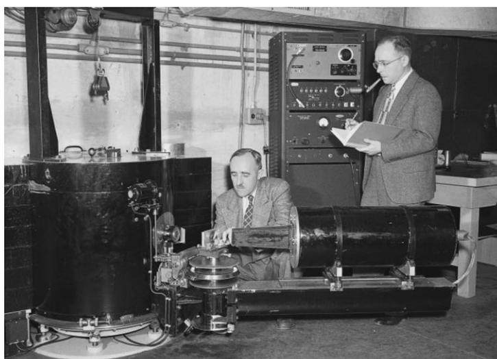
Clifford Shull (derecha) y Ernest O. Wollan con un espectrómetro de neutrones de doble cristal, en el reactor ORNL X-10 de grafito, en 1949.
